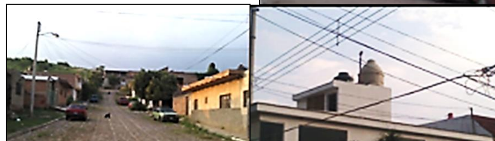
Figura 13. Alumbrado público y electricidad. En sitio 2012.
