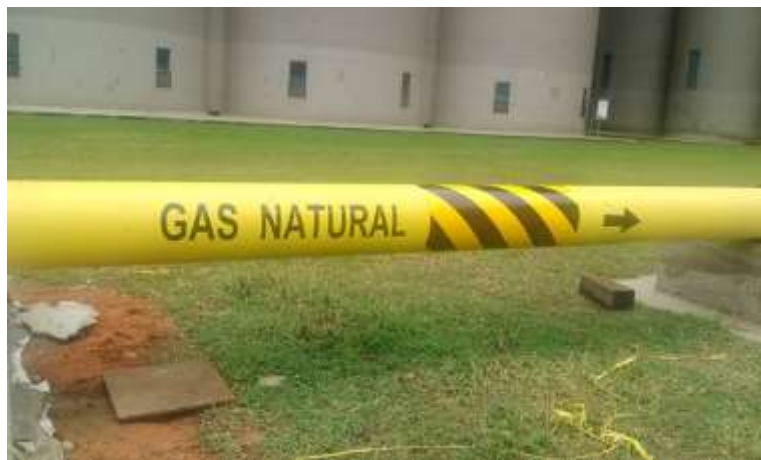
Figura 3.7 Tubería horizontal respecto al nivel de piso.
