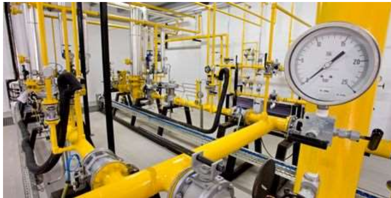
Figura 3.1 Instalación de aprovechamiento de gas natural tipo industrial. Fuente: El Periódico de la Energía
