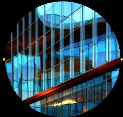
Cristal templado en ventanas, y en cubierta de vano central.
