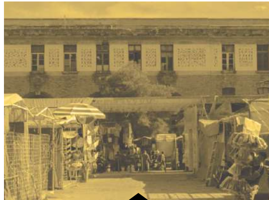
Fig. no. 33 (Arriba). Plaza del Estudiante invadida por comercio informal fijo; al fondo la Honorable Casa del Estudiante, obra maestra de la arquitectura porfiriana, actualmente en estado crítico debido a la falta de recursos.
