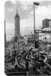
CIUDAD DE MÉXICO, DURANTE EL SISMO DE 1985. (I.11)
