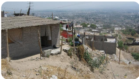
VIVIENDA AUTO PRODUCIDA, A BASE DE MATERIALES DE DESECHO, O RECICLADOS. (I.19)
