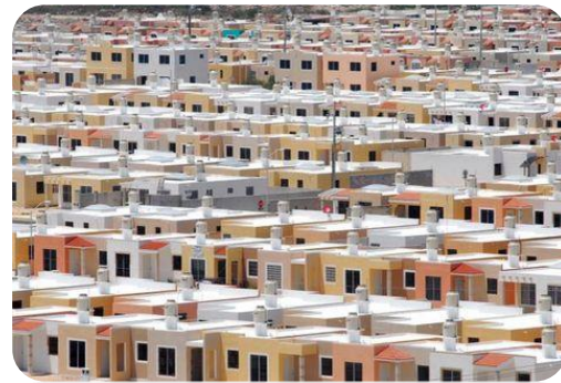
FRACCIONAMIENTO DE VIVIENDAS DE INTERÉS SOCIAL, INFONAVIT, ESTADO DE MÉXICO. (I.14)
