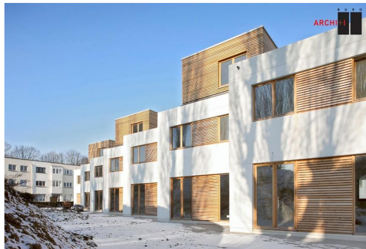
CONJUNTO DE LA VIVIENDA SOCIAL SUSTENTABLE. (I.41)
