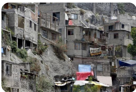
ASENTAMIENTOS DE VIVIENDAS EN ZONAS ILEGALES DE CONSTRUCCIÓN. (I.18)
