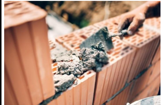
COLOCACIÓN DE LADRILLOS SUSTENTABLES UNICER. (I.113)
