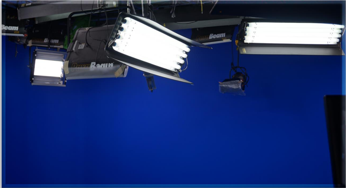
Luces Kino Flo fluorescentes de 5500°k del foro virtual
