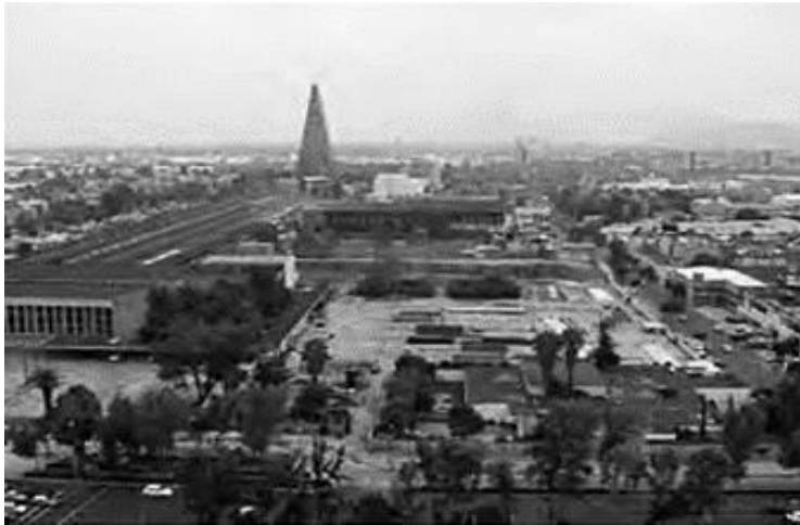
1.1 Terreno destinado para la construcción de la BV
