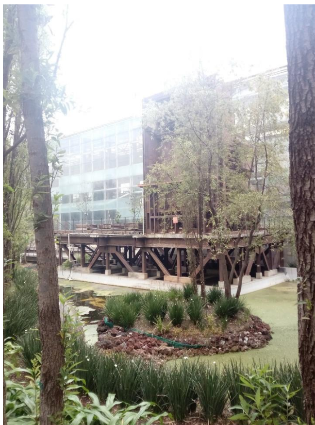
1.4 Estructura de antigua subestación Nonoalco en BV
