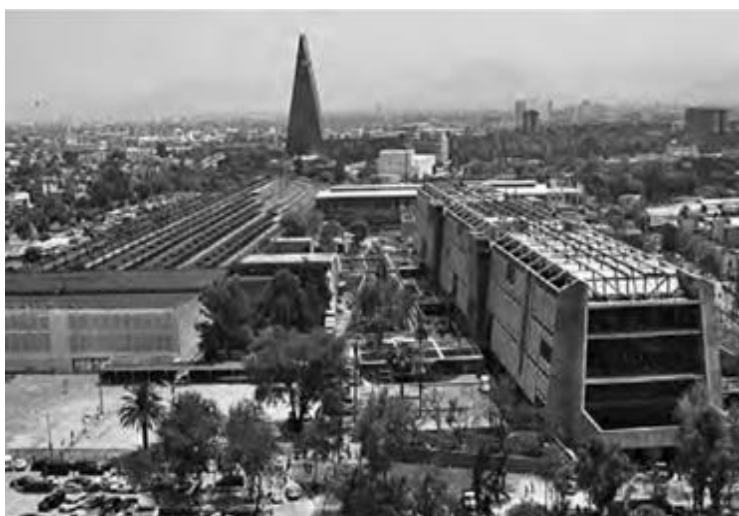
1.3 Edificio que alberga a la BV
