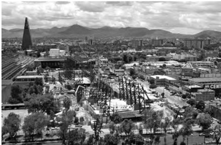
1.2 Obras de construcción de la BV
