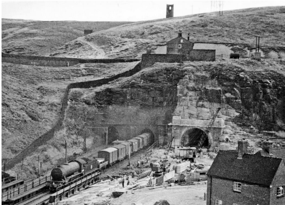
Figura 1.4 Portales al Poniente del túnel Woodhead en 1953. A la izquierda un tren emerge de uno de los túneles originales, mientras que el túnel 3 a la derecha está aún en construcción.
