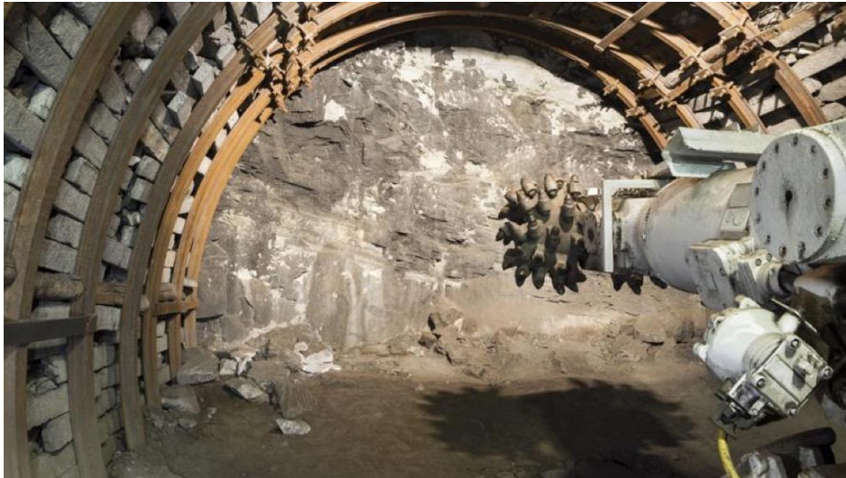
Figura 1.22 Imagen de una rozadora en operación.
