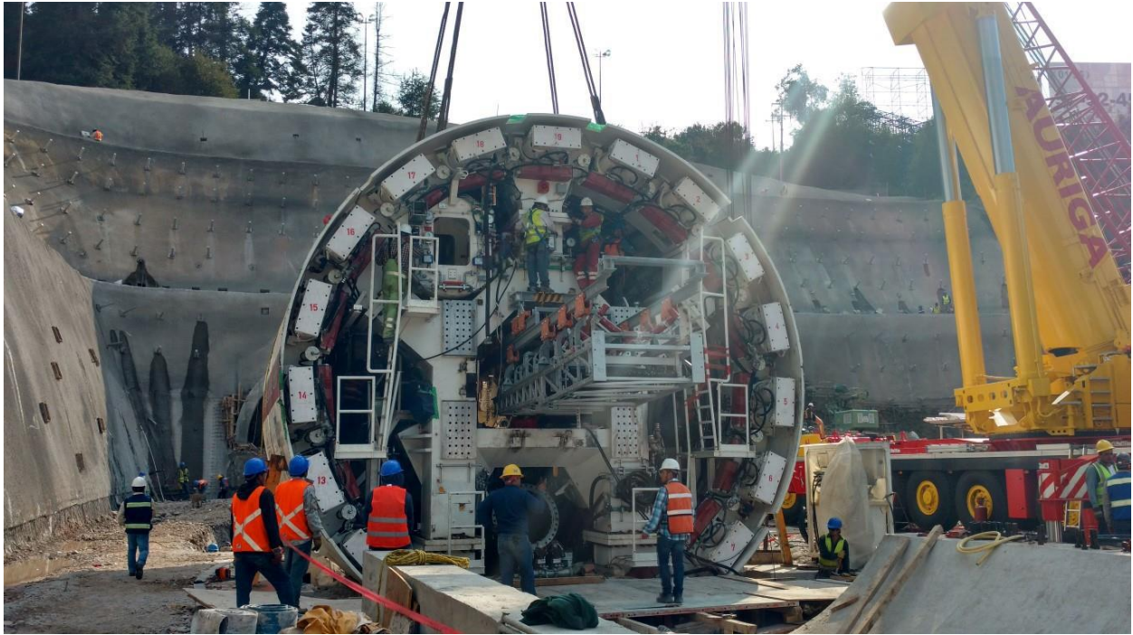
Figura 3.7 Montaje de la rueda de corte.
