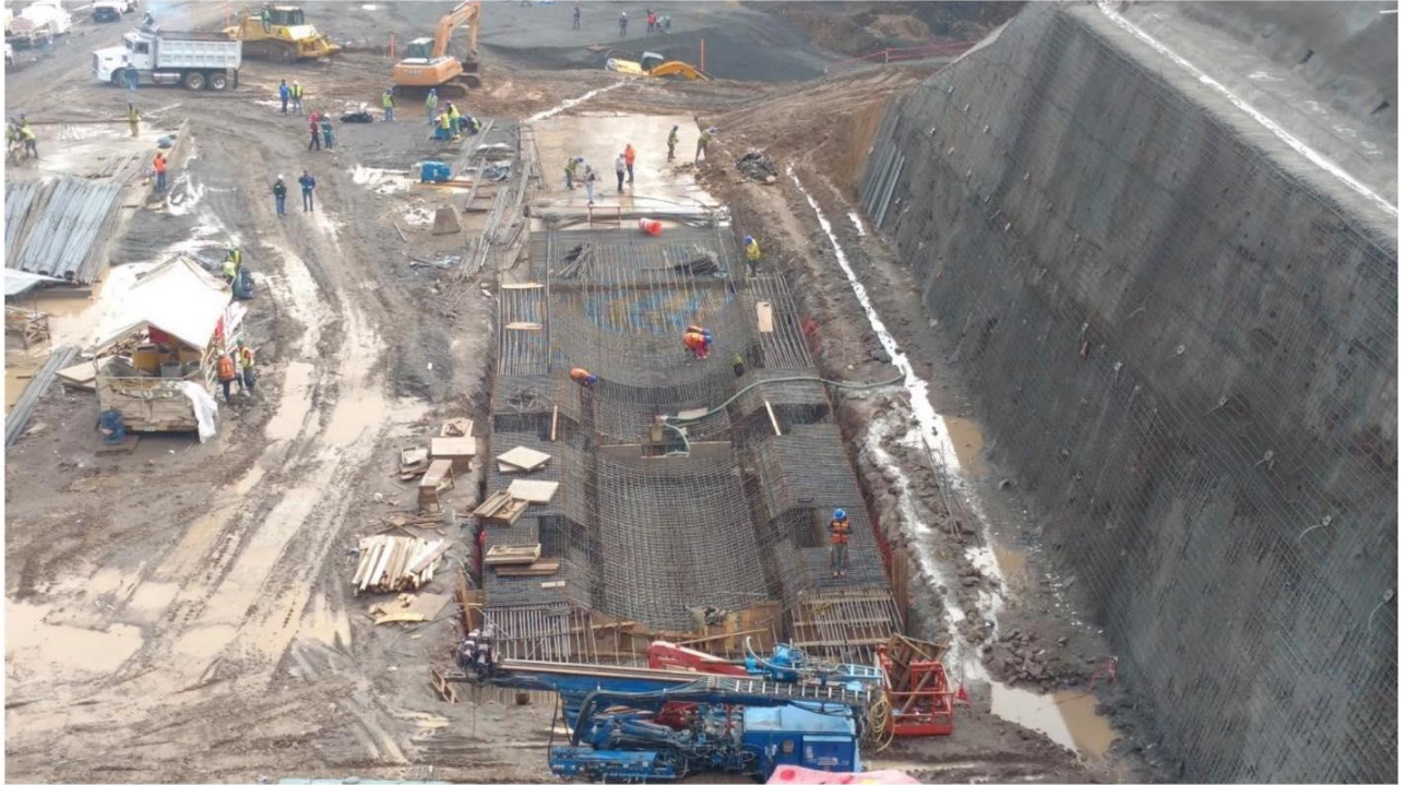
Figura 3.3 Proceso de construcción de la cuna para el armado del escudo.
