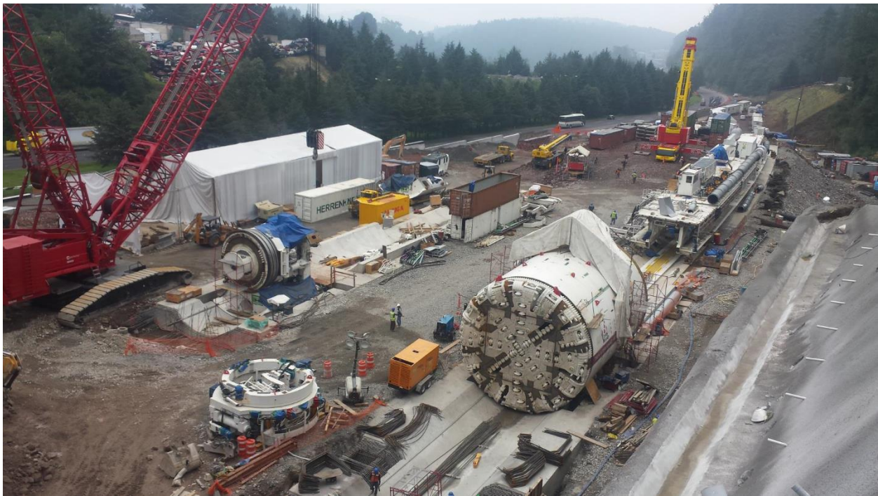
Figura 3.8 Ensamble de una de las dos tuneladoras.
