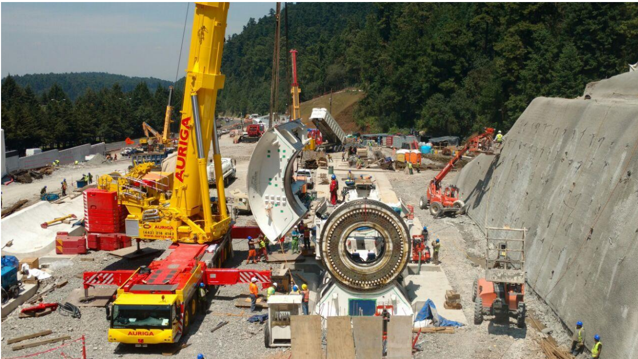
Figura 3.6 Montaje de la tuneladora
