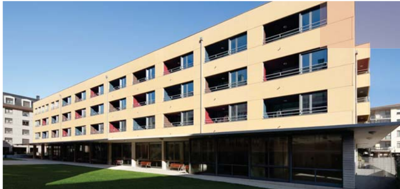
Apartamentos para mayores y centro de día en Zarautz, fotografía: Alejo Bague, fuente: Archdaily México
