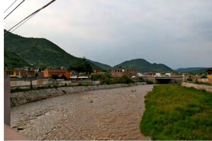
Fotografía 2. Muro de contención a las orillas del río. Fuente: Libro de Tuxpan, Michoacán, 2010.
