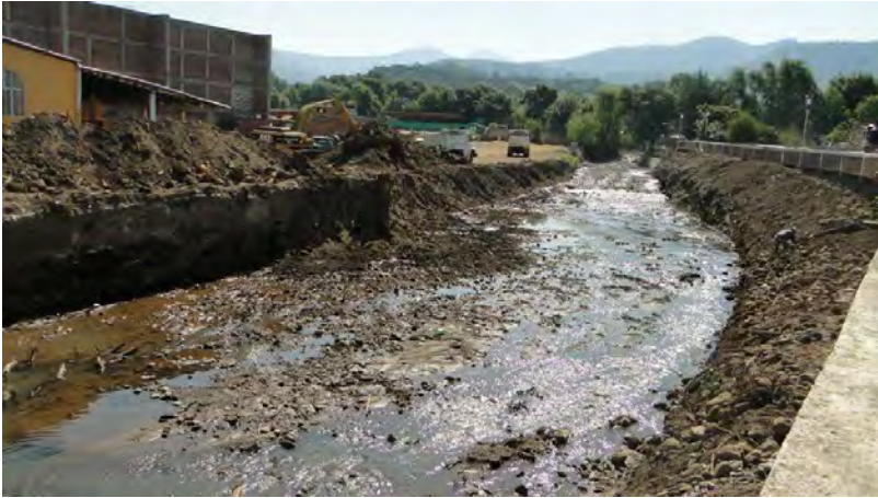
Fotografía 1. Río Tuxpan después de la inundación, Fuente: Blog del Municipio de Tuxpan.
