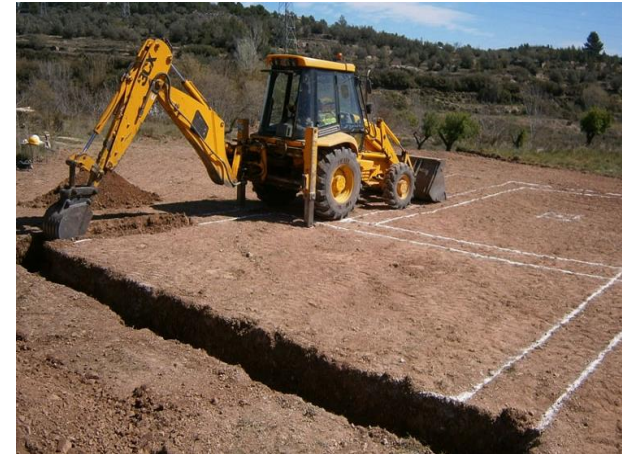
Imagen 106. Maquinaria para excavación.
