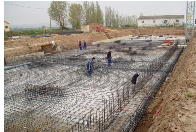
Imagen 109. Armado de Cajones de cimentación.
