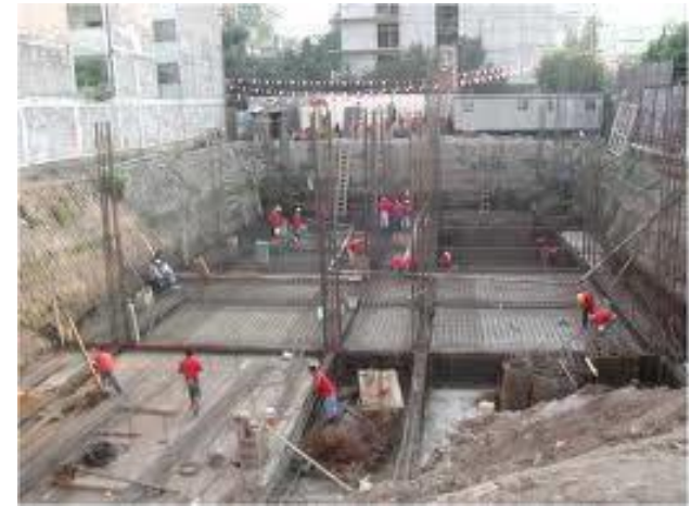
Imagen 104. Cajones de cimentación.
