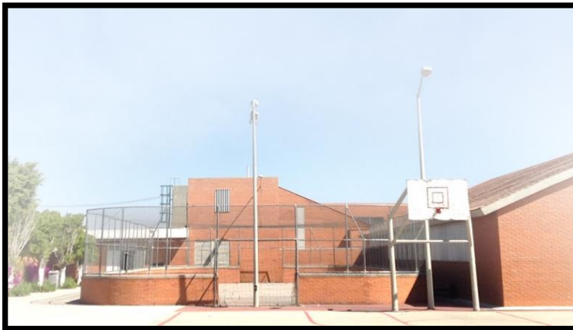
Imagen.1.12. Instalaciones CDC Juan Diego.
