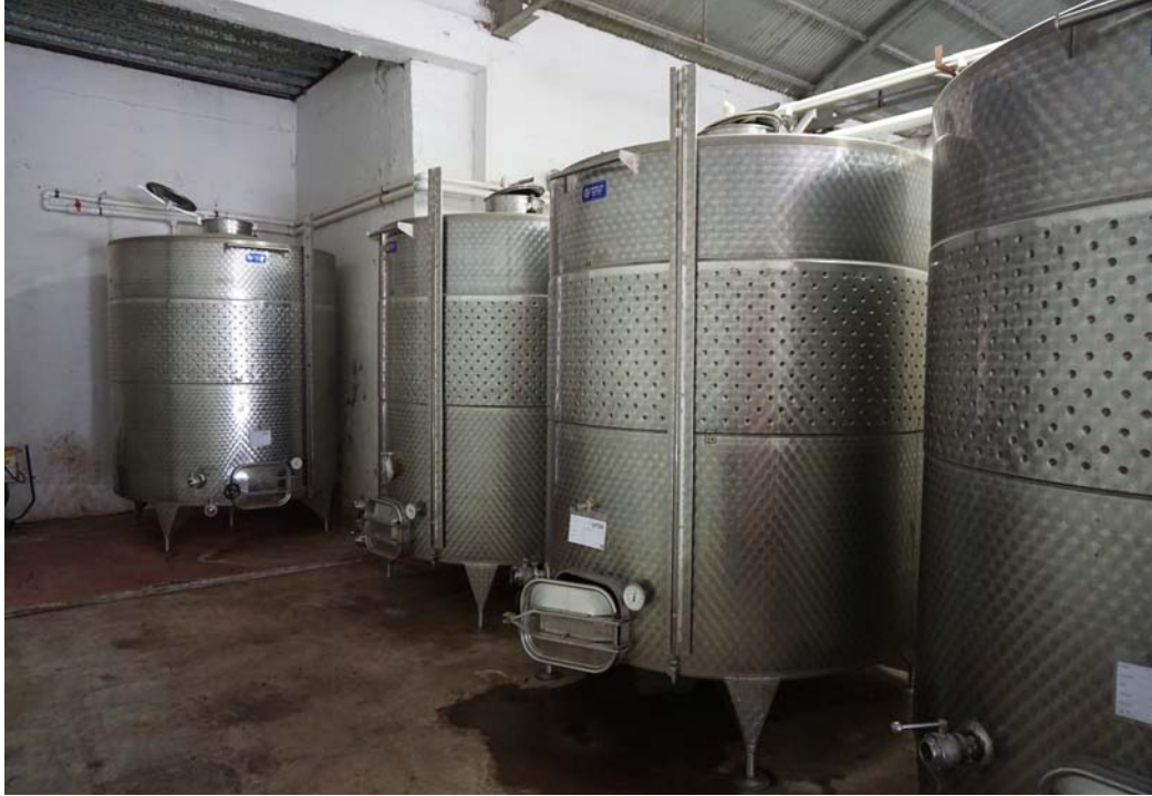
Tanques de acero en la Estación de Oficios Fotografía: Ricardo del Monte
