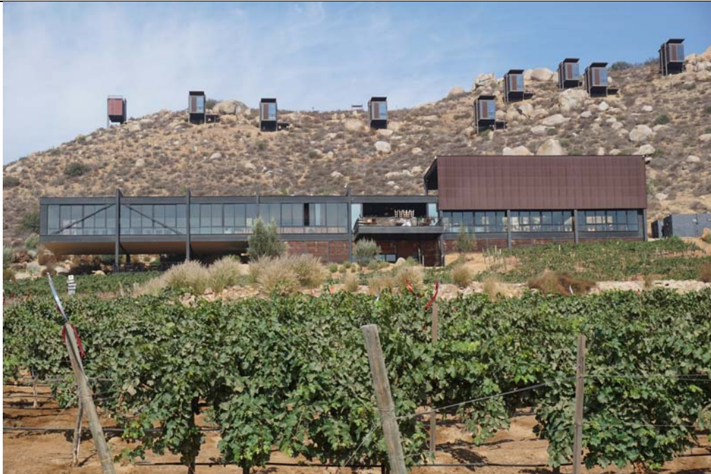
Muestra de arquitectura en el Valle de Guadalupe Fotografía: Ricardo del Monte
