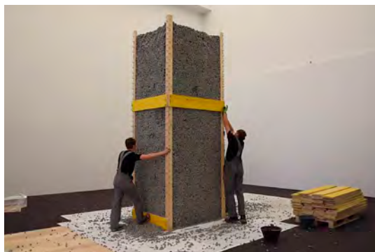
Momento al retirar la cimbra de madera perimetral.
