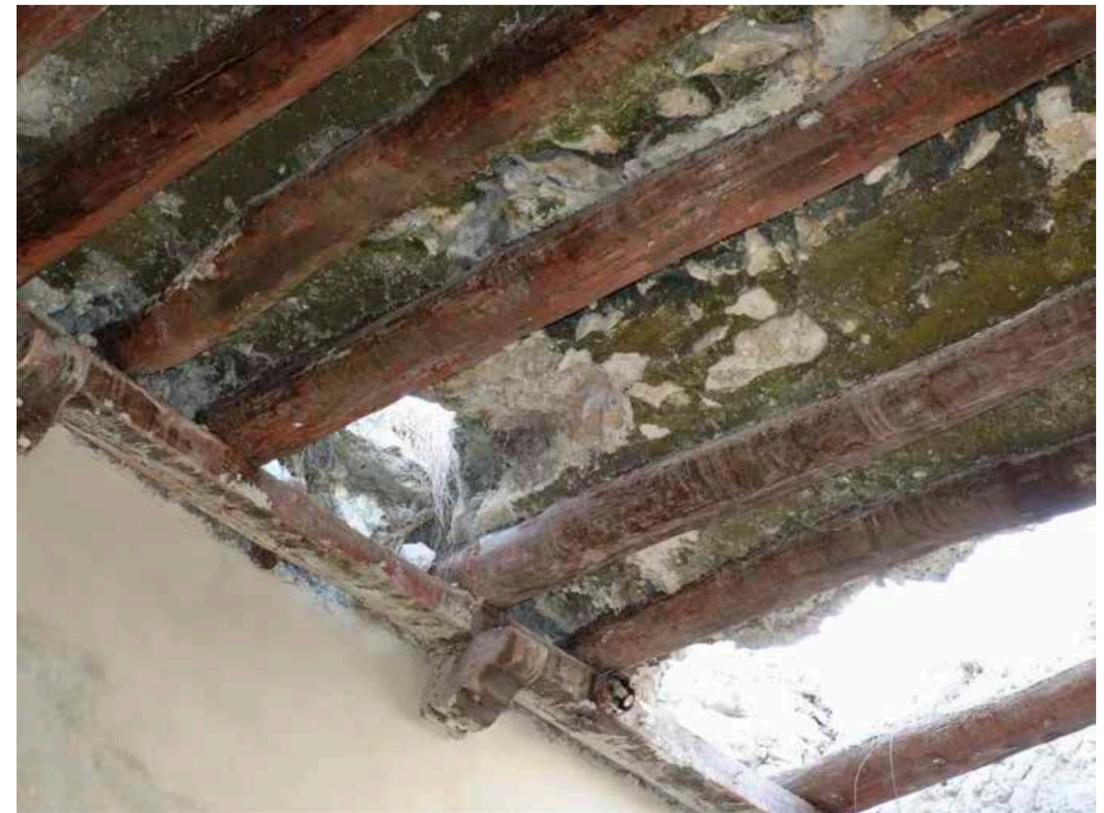
Techumbre de carrizos de madera y terrado de cal típico de la península dañado por la falta de impermeabilización.
