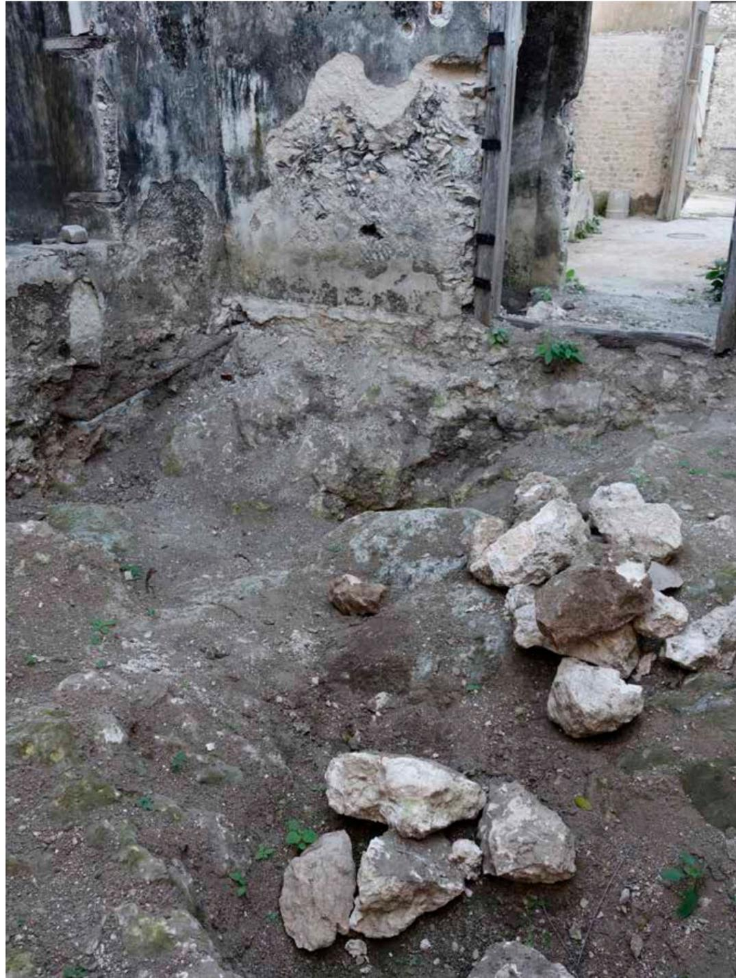
Detalle de la cimentación, sobre piedra caliza y muros de mampostería con mortero de cal.
