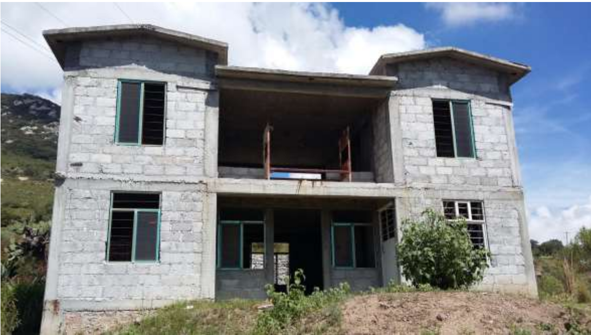
Vivienda en proceso constructivo, Santuario Mapethé.
