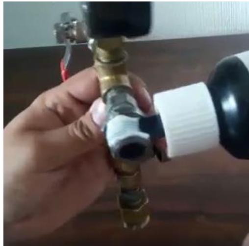
Figura 22. Aplicación de sellador en tubería con cuerda dañada
