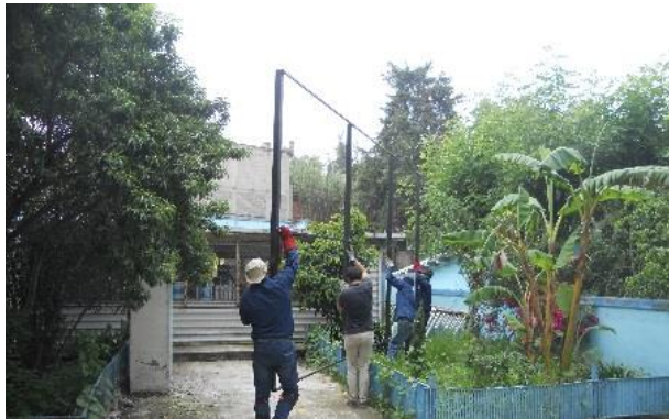
Figura 29. Instalación del sistema
