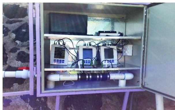
Figura 34. Equipos de medición
