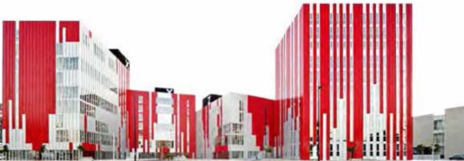
Fachada. VAC Arquitectura. Imagen obtenida de Internet.
