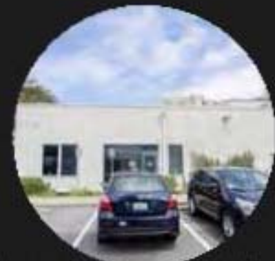
Construcción existente en el predio designado para el proyecto. Architecture Zero. Imagen obtenida de Internet.
