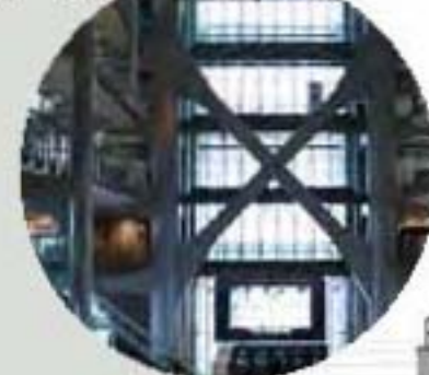
Al interior de un recinto optando por no ocultar la estructura al no usar plafones ni mamparas. La Estructura Como Arquitectura:
