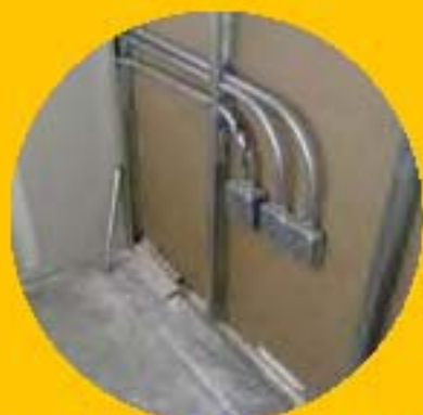
Instalación portubería con remate de caja metálica. Fotografía de autoría propia.
