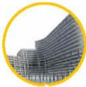
1. Estructura de Edificio A y B.
