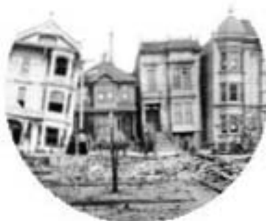
Fotografía tomada después del terremoto de San Francisco. Civitatis San Francisco. Imagen obtenida de Internet.
