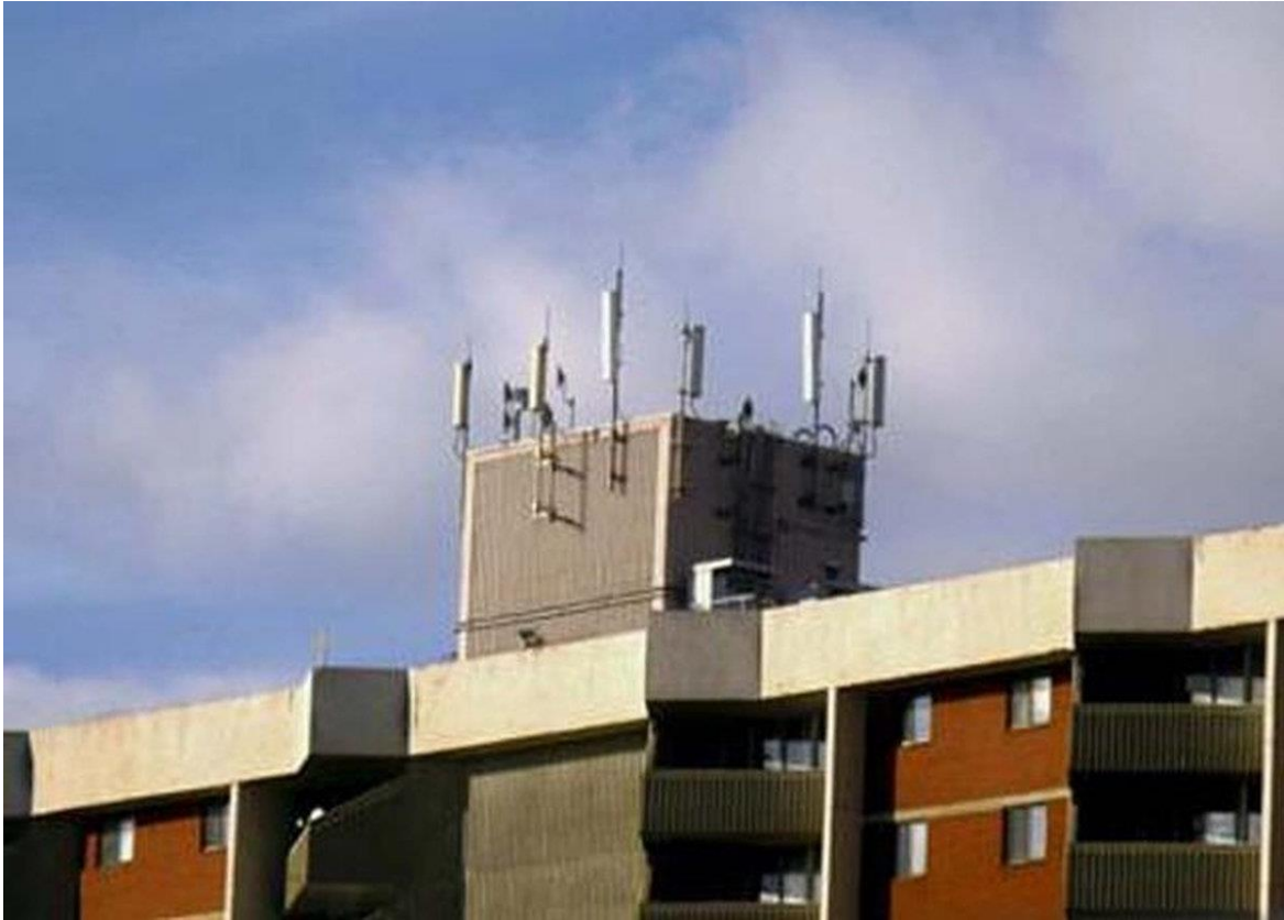
Figura 2.8. Equipos de una radio base en azotea.
