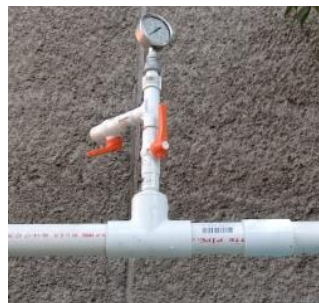
FIGURA 4.5 Manómetro de glicerina, ya conectado a la tubería.
