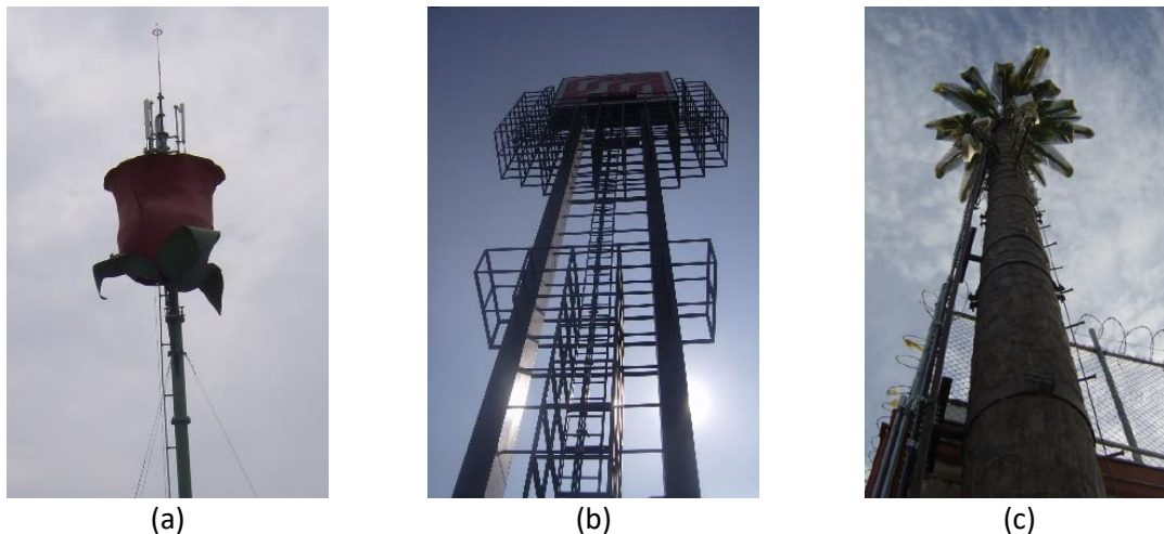
Figura 1.3 (a) Monopolo mimetizado en forma de adorno, (b) torre mimetizada en forma de anuncio espectacular, (c) Torre camuflada en forma de palmera
