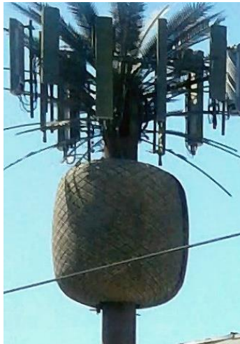
Figura 1.11 Piña artificial en capiteles de monopolo tipo palmera
