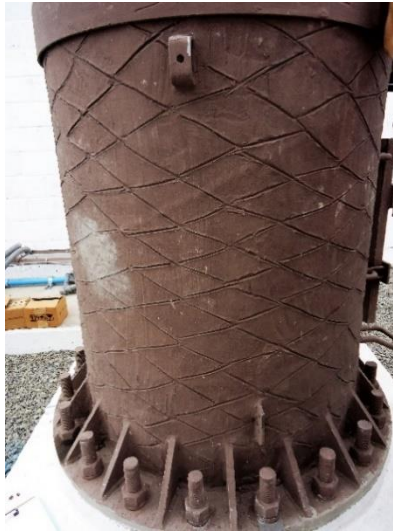
Figura 1.9 Acabado de resina plástica sobre el fuste del monopolo
