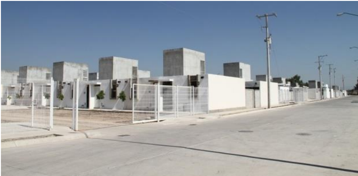
Gráfico 25. Vista del acceso vehicular del conjunto mediante un portón de malla electrosoldada. Fuente: (eSTUDIO vS, 2011).
