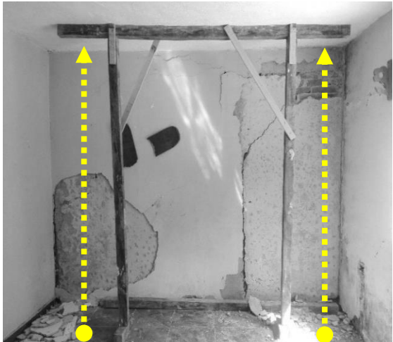
Fotografía 5. Vista del apuntalamiento de la recámara 3. Fotografía de: HMAC (2017).
