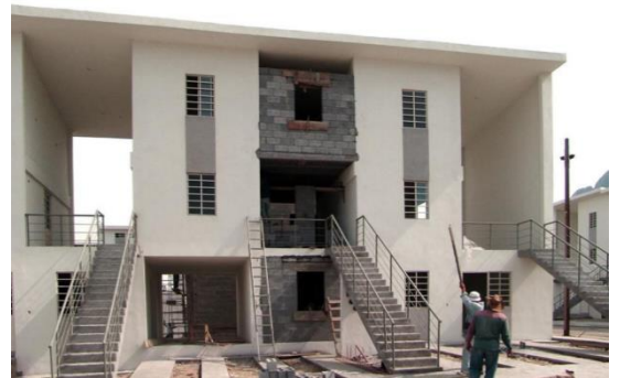
Gráfico 14. Ejemplo de ampliación de las viviendas. Fuente: (ELEMENTAL, 2010)
