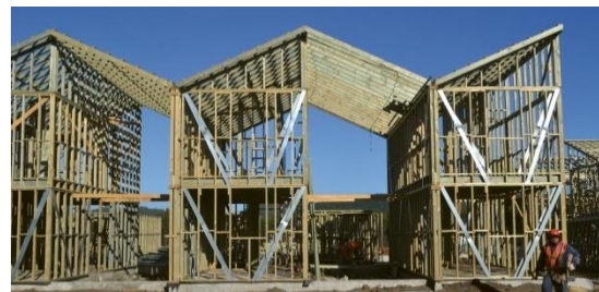
Gráfico 6. Módulos de vivienda en construcción. Fuente: (ELEMENTAL, 2013)
