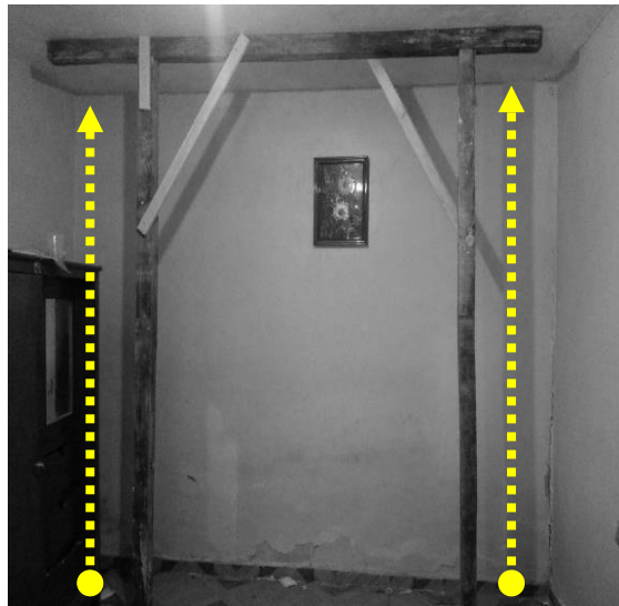
Fotografía 3. Vista del apuntalamiento de la recámara 1. Fotografía de: HMAC (2017).
