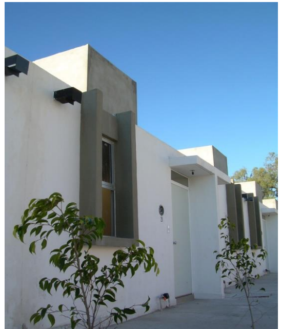
Gráfico 22. Vista del acceso a la vivienda en primera etapa. Fuente: (eSTUDIO vS, 2011).
