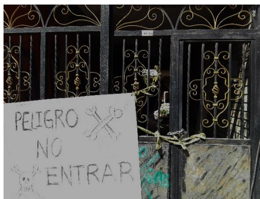
Imagen 3. Fotografía de HMAC (2017). Algunas viviendas tuvieron afectaciones estructurales muy graves con riesgo de colapso.
