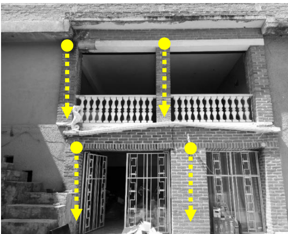
Fotografía 1. Vista frontal de la única fachada de la vivienda preexistente. Fotografía de: HMAC (2017).
