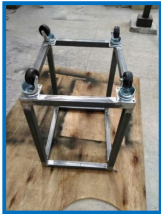
Fig. 86 Estructura con las ruedas soldadas.
