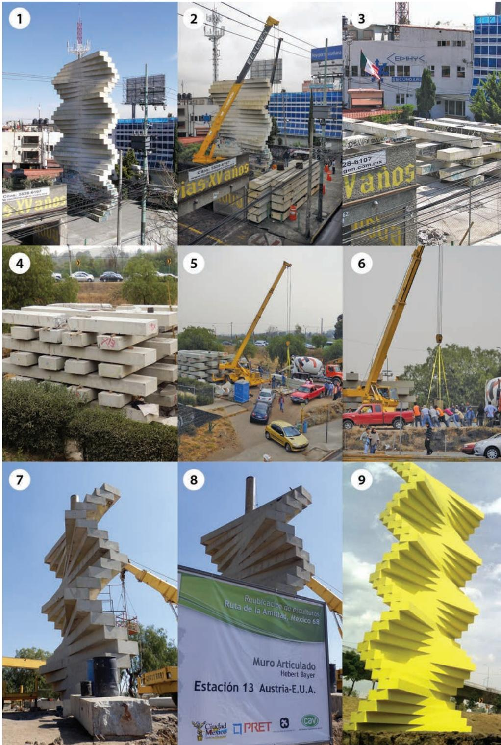
**Imagen 13.** Proceso de reubicación de *El Muro Articulado* en 2013: 1. Aspecto de la obra en su ubicación original. 2 y 3. Separación de todos sus módulos. 4. Traslado y restauración de los bloques a la nueva ubicación. 5, 6, 7 y 8. Unión de los bloques. 9. Aspecto final de la obra totalmente restaurada en su ubicación actual. (fotografías tomadas por el autor)
