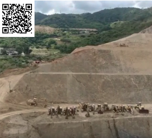
Ilustración 24. Supervisión de obras de construcción, Caracas, Venezuela © Geodesíamania 2017.
