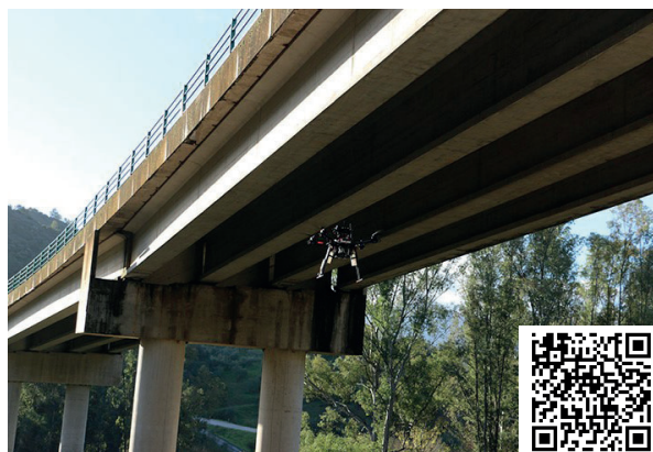
Ilustración 25. Dron articulado con sensores y cámaras para evaluación de puentes © Proyecto AEROBI 2018
