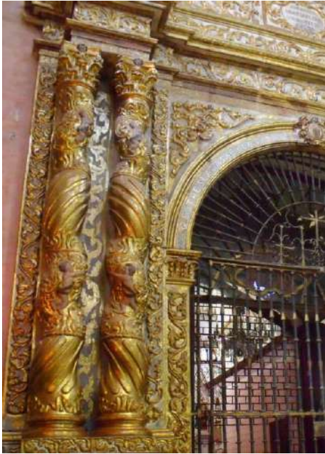
23. Detalle de las columnas salomónicas de la fachada de la Capilla de Loreto, Oratorio de San Felipe Neri, San Miguel de Allende.
