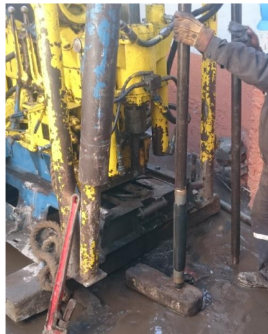
Figura 141. Instalación de la sonda tipo Ménard en el interior de perforación (Sondeo SP-1 ). MKE Ingeniería en suelos S.A. de C.V. (2017).
