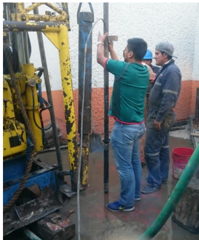
Figura 140. Colocación de los tubulares y/o tubos de plástico (de agua y gas), emparejados, de la sonda Ménard , a las barras de perforación. MKE Ingeniería en suelos S.A. de C.V. (2017).
