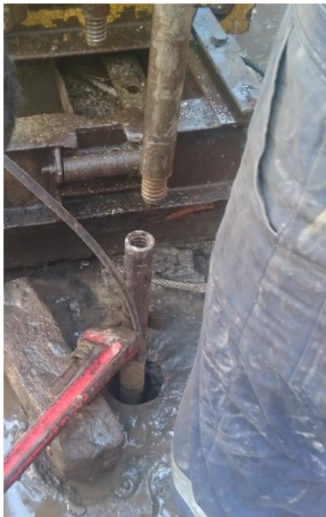
Figura 144. Instalación de la sonda Oyometro en el interior de la perforación (Sondeo SP-2). HP Ingeniería, suelos y cimentaciones, S.A. de C.V. (2017).
