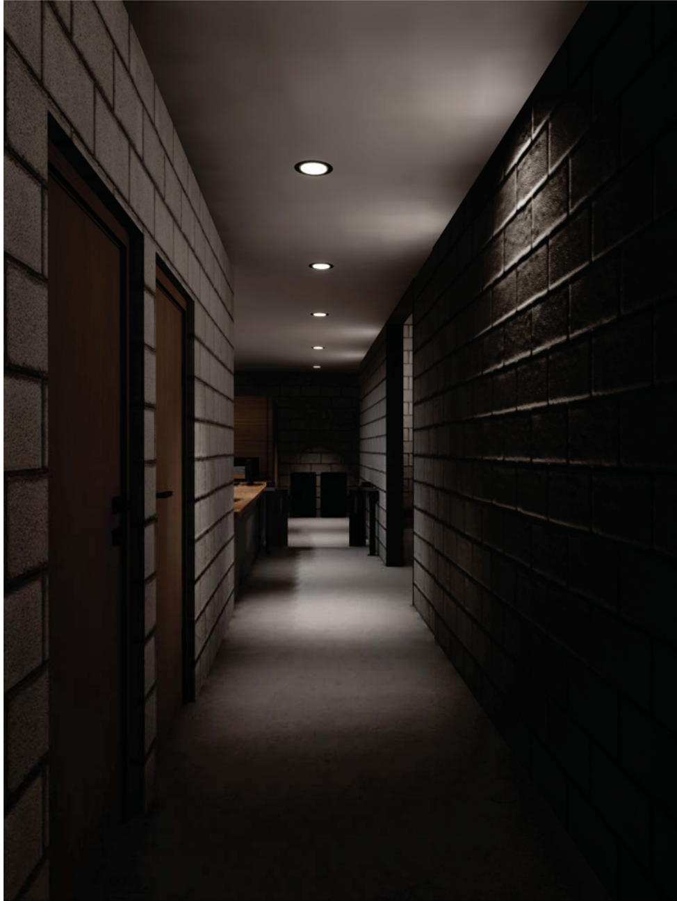
Control de acceso
