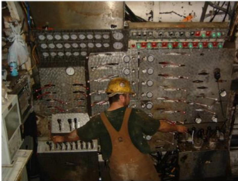
Figura 1.7 Operación de una TBM en los años 90's. (www.tunnelsoft.com).
