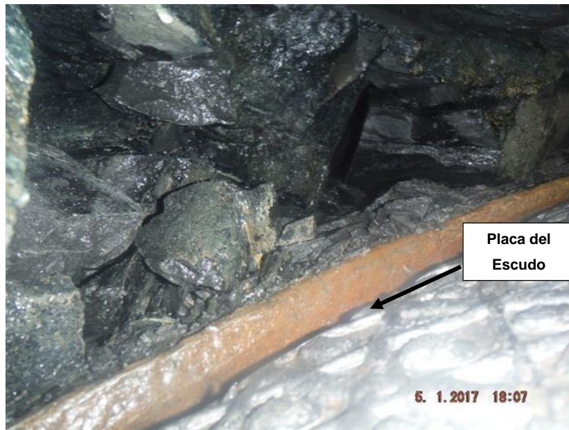
Figura 5.11 Vista desde el frente de excavación hacia el faldón de la EPB, COMISSA 2017.
