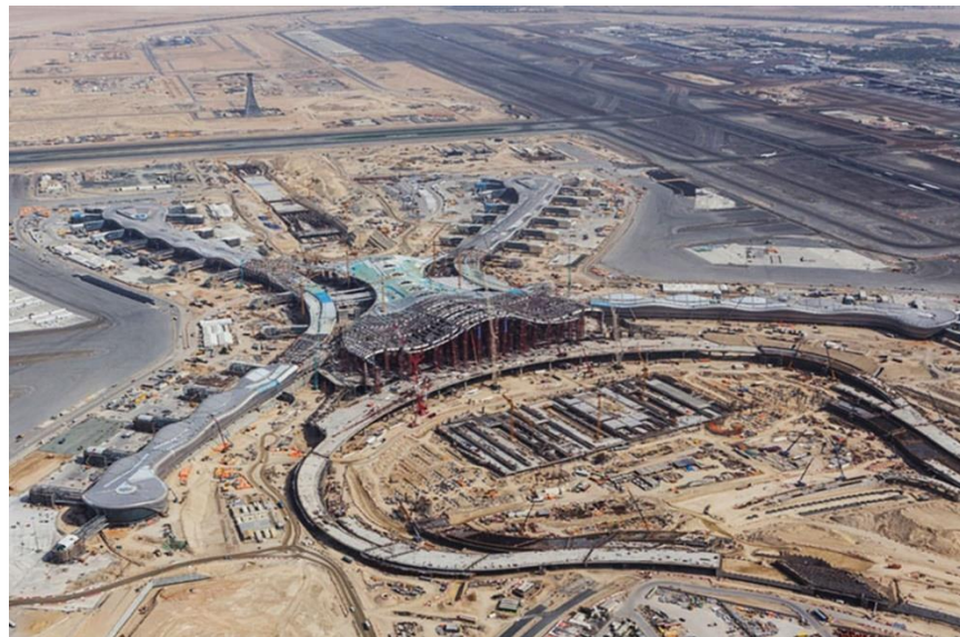
Figura 2.4 Construcción del nuevo edificio terminal del Auh [7]
