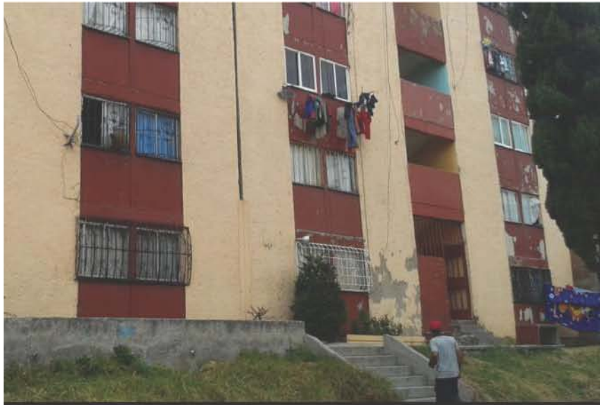
I 139. Edificaciones de vivienda. UH San Francisco I, II y III. Estado previo al mejoramiento.
