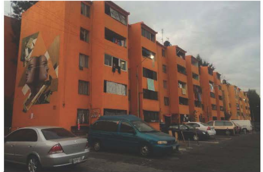
I 166. Edificaciones de vivienda. UH San Lorenzo. Estado posterior al mejoramiento.
