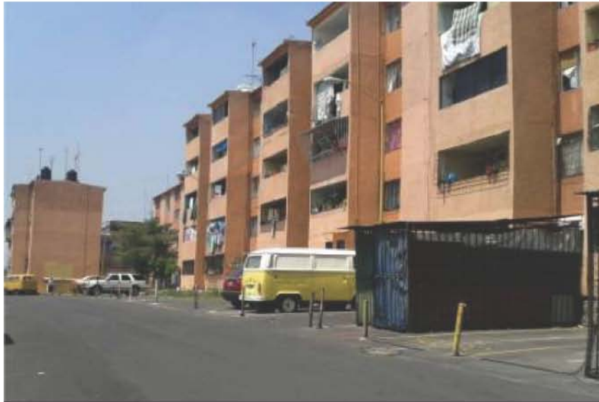
I 165. Edificaciones de vivienda. UH San Lorenzo. Estado previo al mejoramiento.
