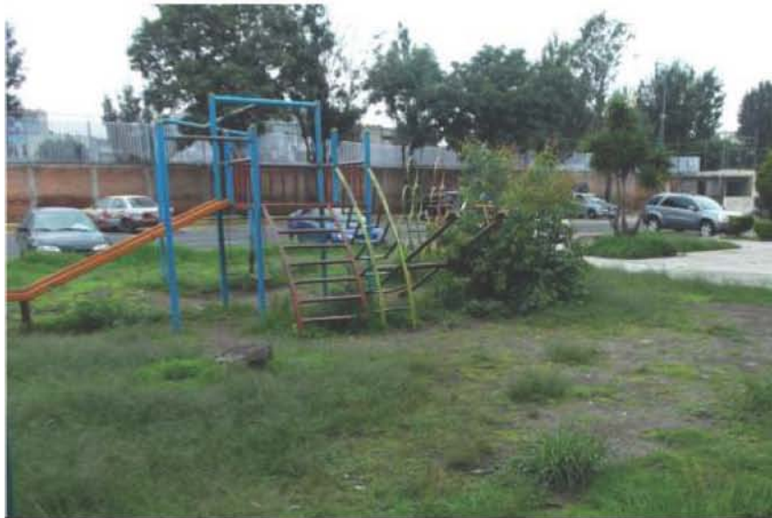
1089. Área recreativa, UH Tejocotes. Estado previo al mejoramiento.
