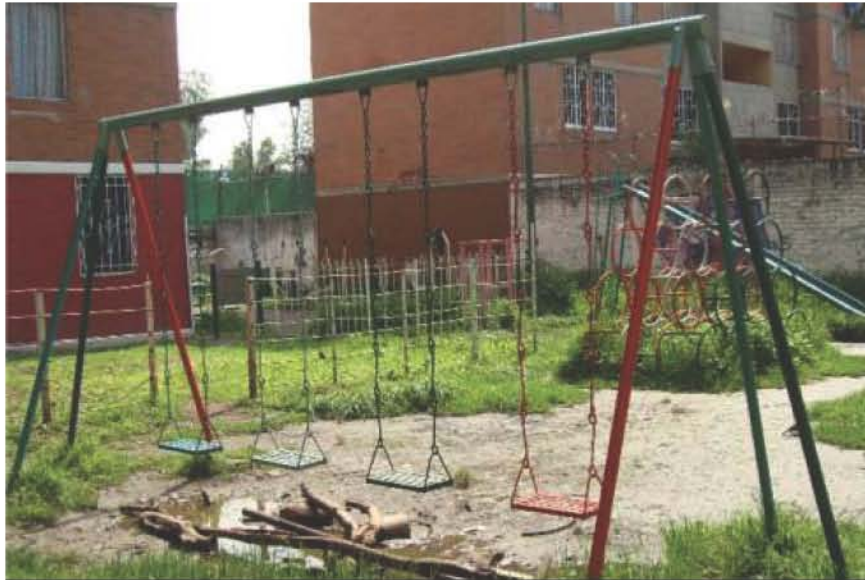
I 306. Área recreativa. UH San Pablo Xalpa E-F. Estado previo al mejoramiento.
