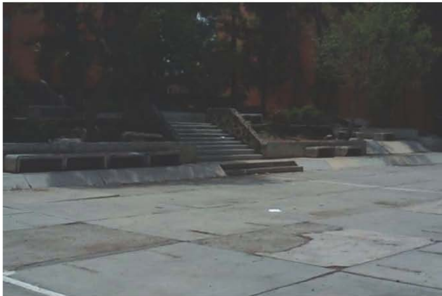
I 167. Área recreativa. UH San Lorenzo. Estado previo al mejoramiento.
