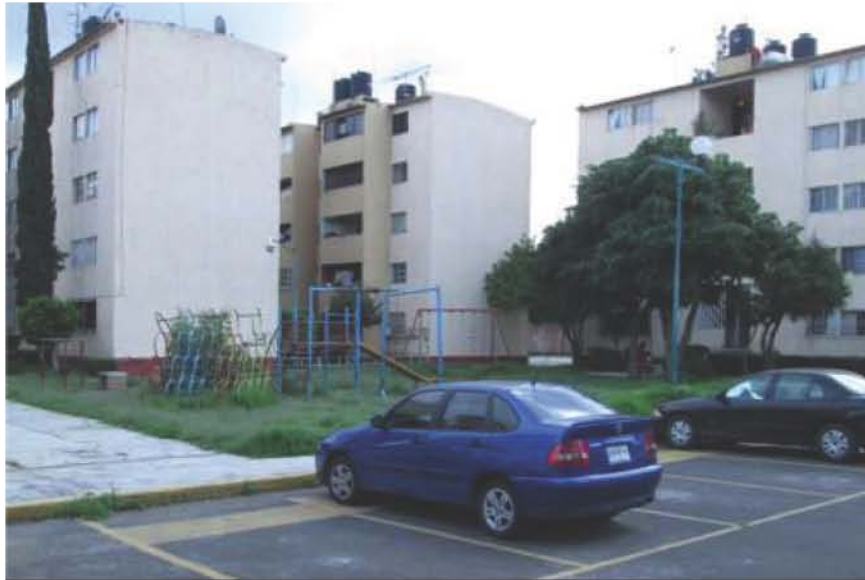
1087. Edificaciones de vivienda, UH Tejocotes. Estado previo al mejoramiento.
