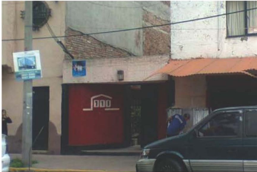
I 061. Acceso peatonal. UH Anáhuac II. Estado previo al mejoramiento.
