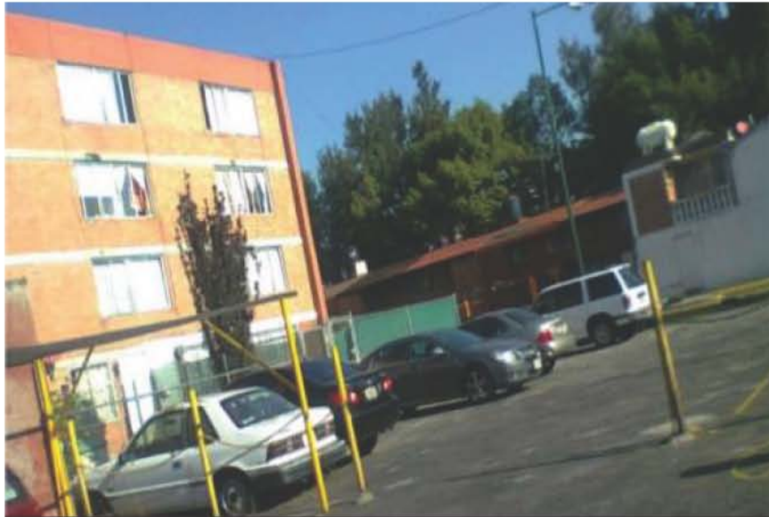
I 243. Edificaciones de vivienda. UH El Hueso Vergel. Estado previo al mejoramiento.
