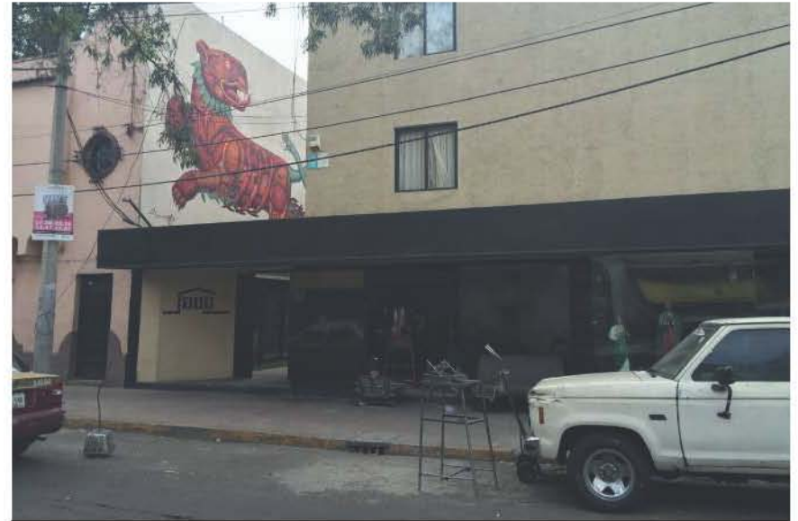
I 062. Acceso peatonal. UH Anáhuac II. Estado posterior al mejoramiento.
