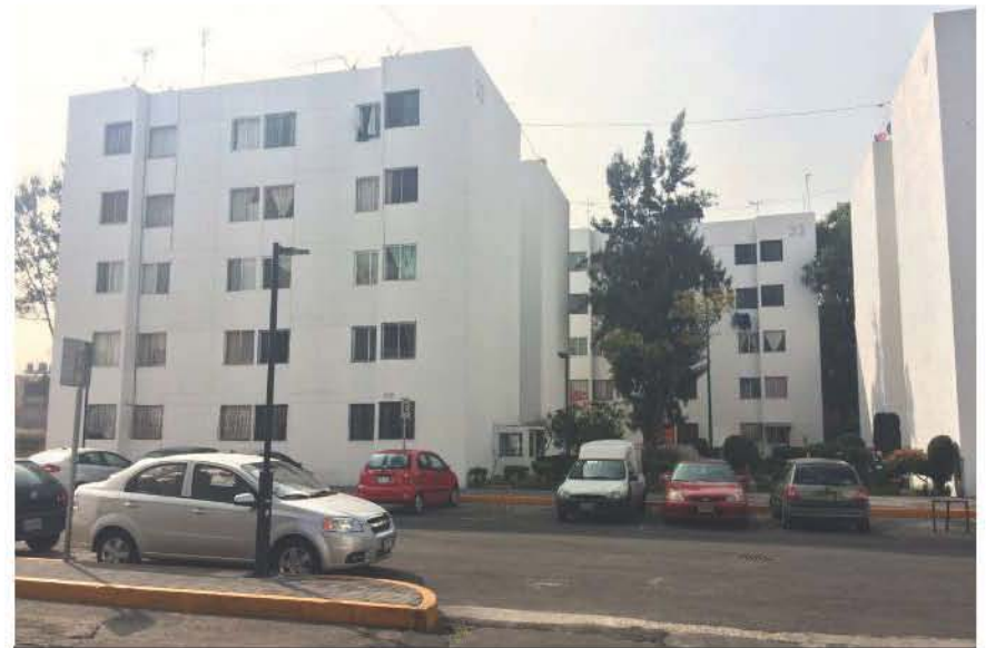
I 270. Edificaciones de vivienda, UH Cuernavaca I y II. Estado posterior al mejoramiento.
