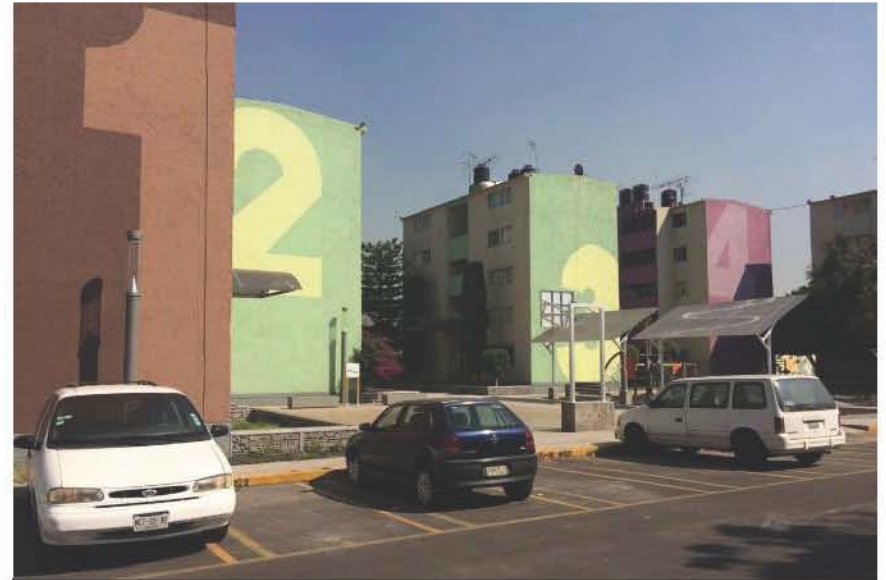
1088. Edificaciones de vivienda, UH Tejocotes. Estado posterior al mejoramiento.
