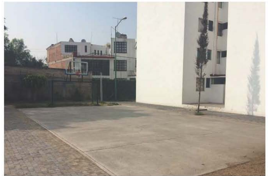
I 272. Área recreativa, UH Cuernavaca I y II. Estado posterior al mejoramiento.
