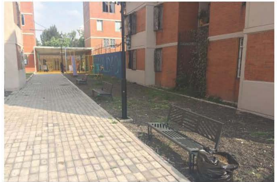
I 309. Área recreativa. UH San Pablo Xalpa E-F. Estado posterior al mejoramiento.
