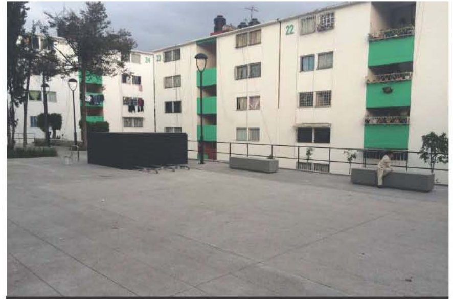
I 140. Edificaciones de vivienda. UH San Francisco I, II y III. Estado posterior al mejoramiento.
