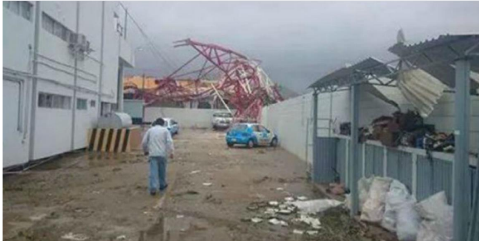
Figura 1.3. Torre de telecomunicaciones en San José del Cabo.
