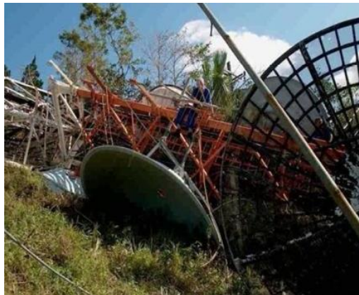
Figura 1.7. Torre de telecomunicaciones tras el paso del huracán Michelle.
