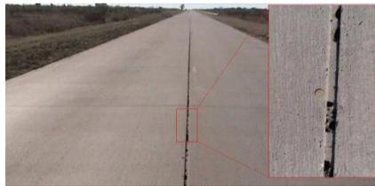
Imagen 2.3 Junta longitudinal en pavimento.
