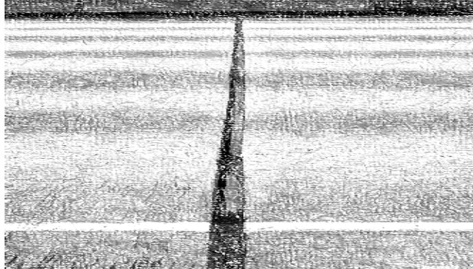
Imagen 2.2 Junta transversal en pavimento.
