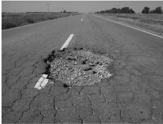
Imagen 2.6 Falla de carpeta asfáltica.
