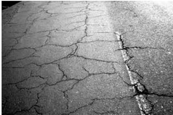
Imagen 2.5 Grietas en carpeta asfáltica.
