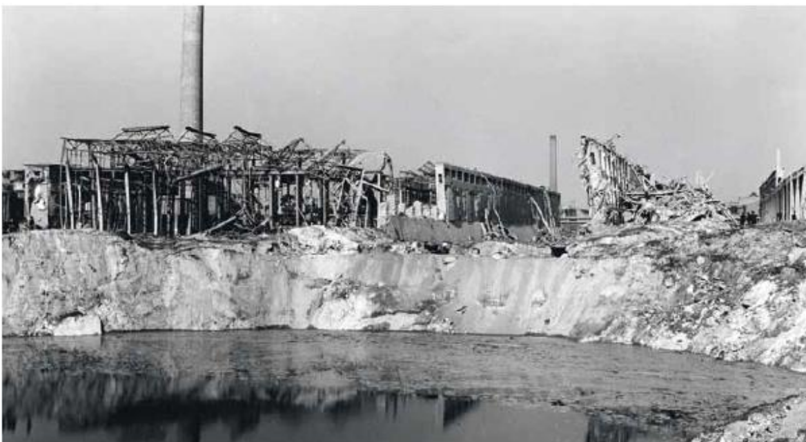
FIGURA 2.5 MUESTRA LA DESTRUCCIÓN EN LA PLANTA DE OPPAU EN 1921.
