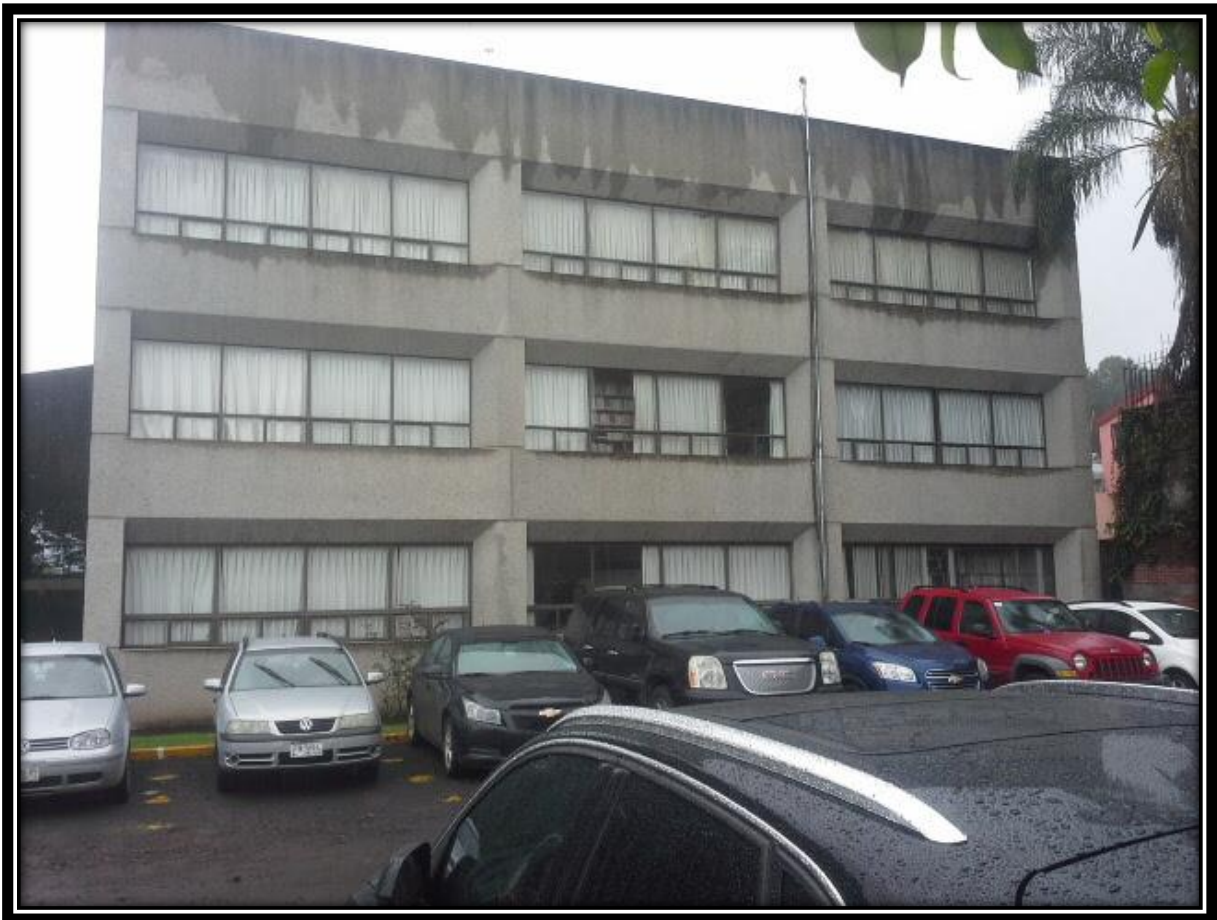
Imagen 4.16 Vista lateral del edificio de la biblioteca. (Fuente: Propia).
