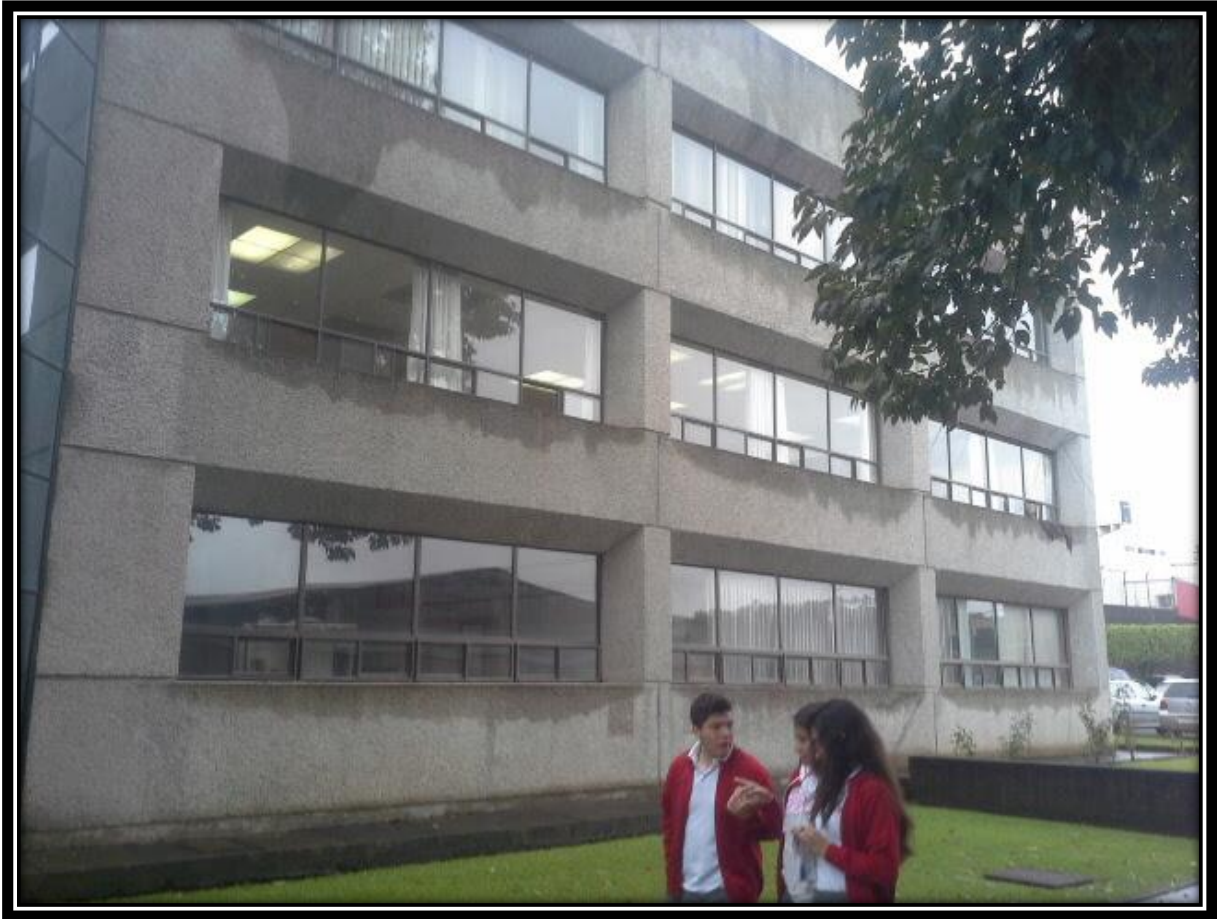
Imagen 4.15 Fachada del edificio de la biblioteca. (Fuente: Propia).
