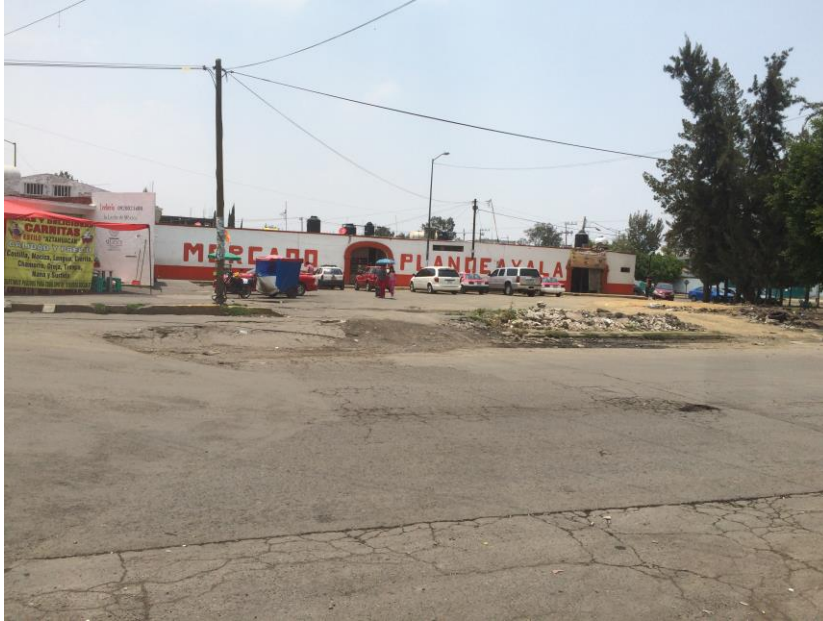
Fotografía 11. Vista de asentamientos diferenciales en la calle plan de Ayala al nor- reste del predio. 2018
