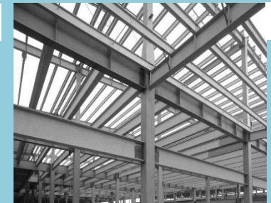
4 Elementos metálicos en la estructuración de los edificios.
