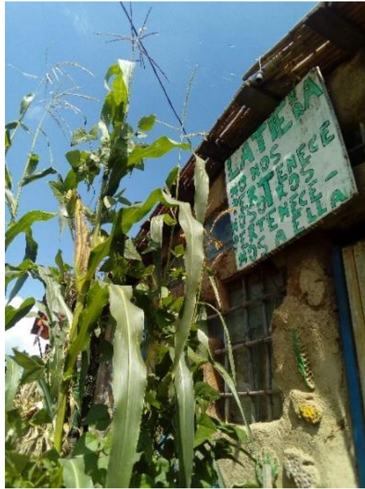
Figura 14. Fachada principal de la “casita comunal” de la CEJM
