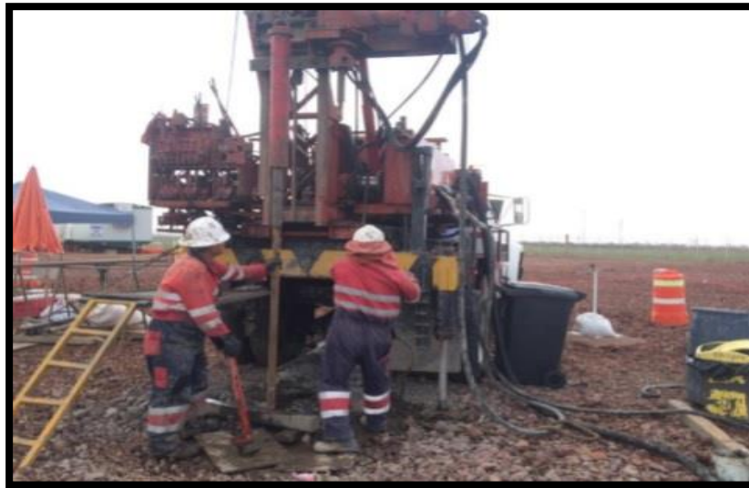
Figura 1.7 Mobile Drill B-64 para la prueba de penetración estándar (6)
