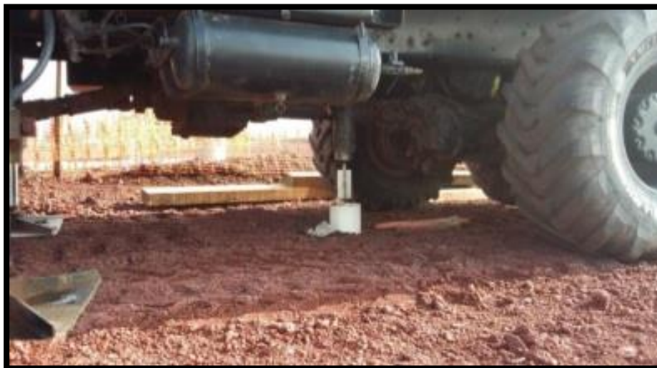
Figura 3. 15 Calibración de veleta de 75 mm al aire antes del hincado en el suelo (20)
