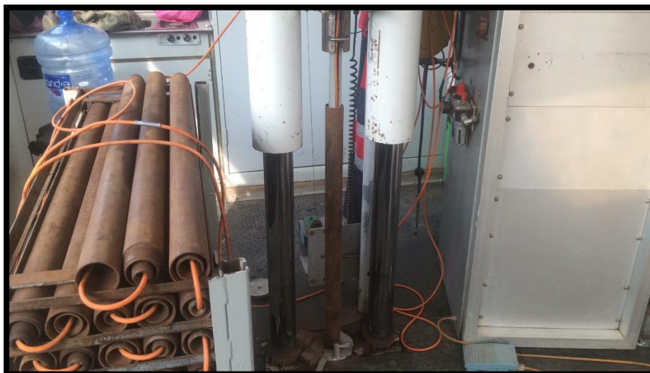
Figura 3. 4 Equipo hidráulico de hincado en operación (16).
