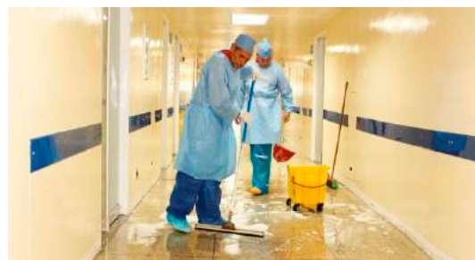
Fig.45. Desinfección de pisos 69
