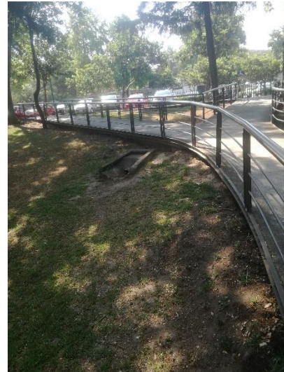
Imagen 42: Zona verde de filtración. Talud y tubería de conducción hacia la zona de filtración de agua. Fuente Propia
