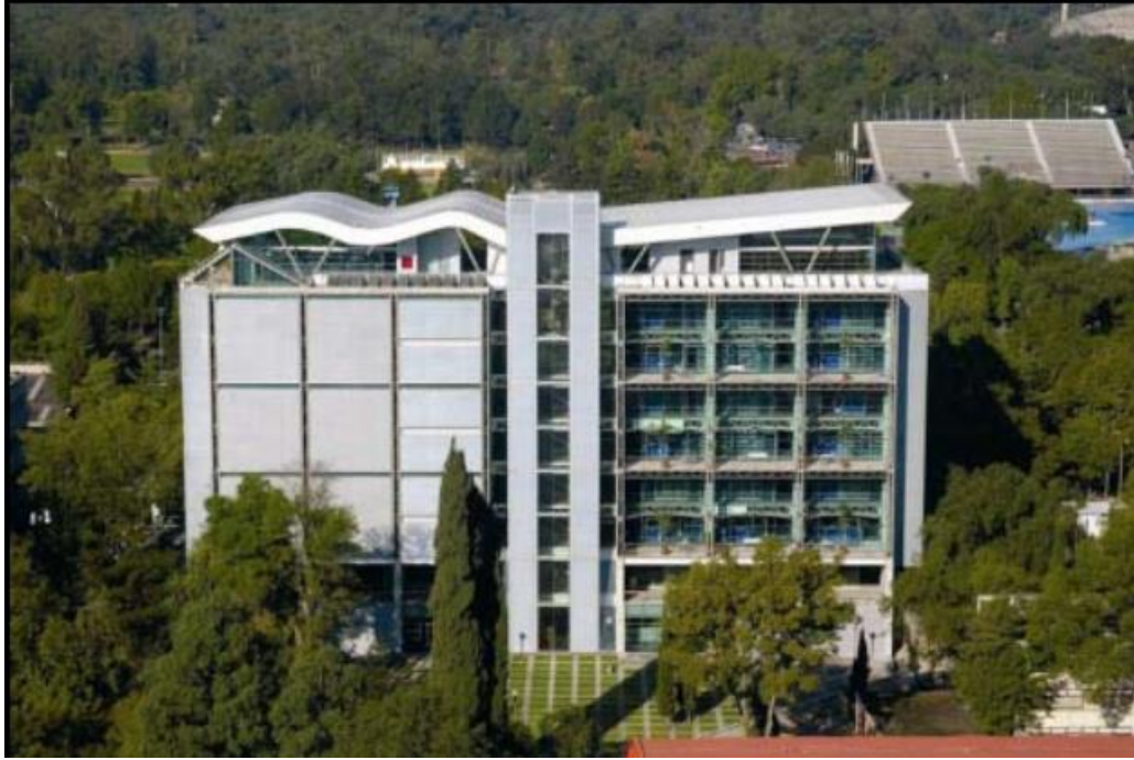
Imagen 41: Torre de Ingeniería. Fuente: Adtec soluciones
