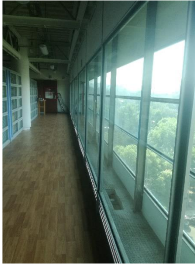
Imagen 73: Situación actual. Doble fachada Norte-Sur. Reducción del paso del aire. Fuente propia
