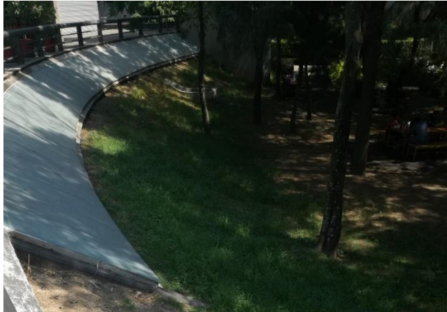
Imagen 56: Plaza de acceso principal: Sistema de ingreso de luz natural al interior de los niveles subterráneos. Fuente: Propia
