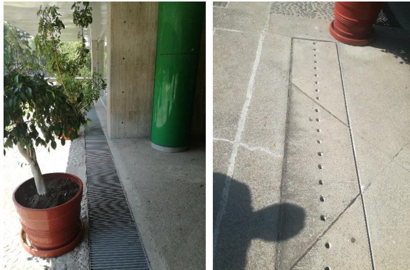
Imagen 44: Conductores de agua de borde del edificio. Fuente propia.
