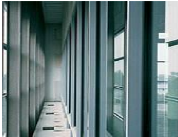
Imagen 61: Situación anterior :Doble fachada Norte-sur. sistema de ventilación y climatización pasivo, (circulación natural del aire por convección con cero consumo de energéticos) Por Yolanda Bravo Saldaña
