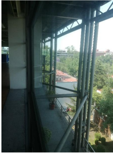
Imagen 63: Fachada Oriente desde el nivel 3. Sistema de terrazas para reducir incidencia solar. Fuente propia.
