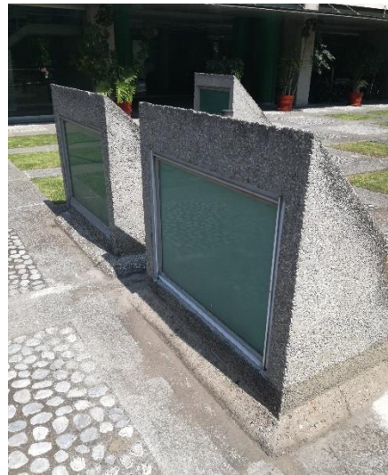
Imagen 57: Plaza de acceso principal: Sistema de ingreso de luz natural al interior de los niveles subterráneos. Fuente: Propia
