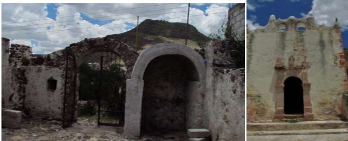
Imagen IX.98 Vistas exterior, fachada y calvario de la capilla de Los Ángeles músicos, Tierra Blanca Gto., Foto BIPP agosto 2013.
