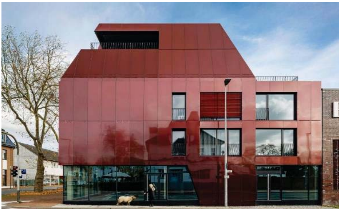
Figura 25.2 Fachada norte con accesos independientes a áreas públicas (centro) y privadas (izquierda).
