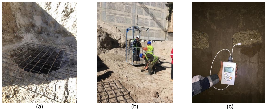
Figura Anexo C.1. Determinación experimental in-situ de propiedades térmicas en el suelo de Santa Fe: a) Excavación. b) Medidas de seguridad. c) Medición con el equipo de la aguja térmica.
