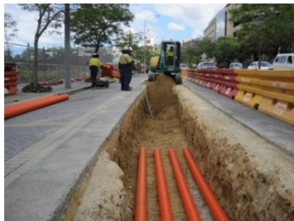
Figura 1.7. Sistema de cableado subterráneo (Odisha Sun Times, 2016).
