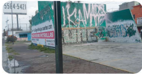
Frontones y cancha en malas condiciones.
