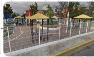
Ancho de banquetas inadecuado
