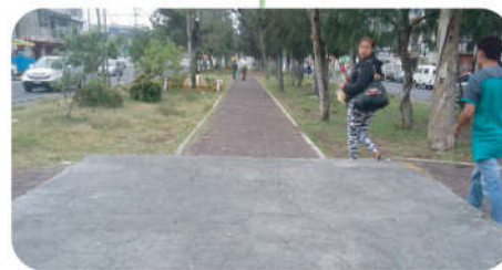
Plataforma de concreto, ningún uso en especial, obstáculo para peatones.
