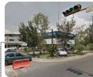
Caseta de vigilancia
