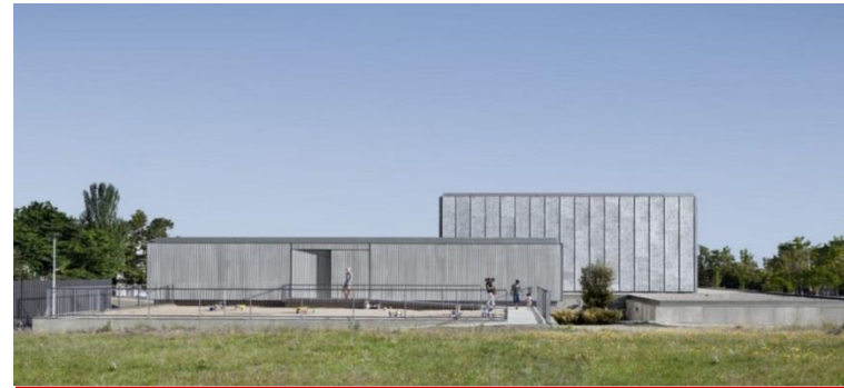
Fachada Sur. Fuente. ArchDaily.
