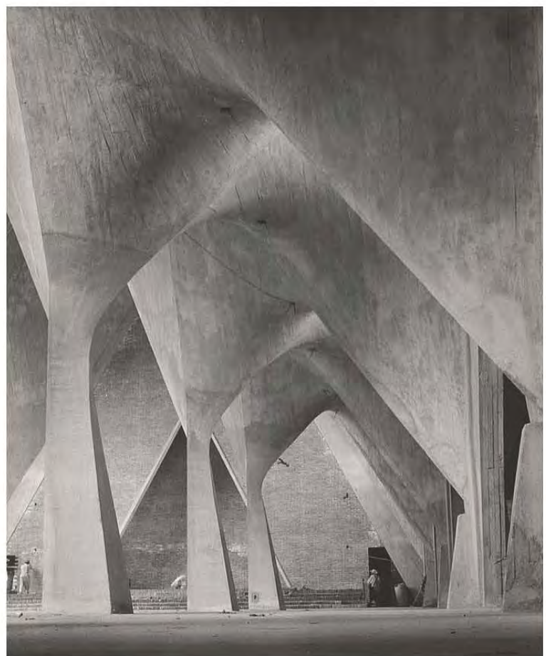
Imagen 4 Cascarón utilizado en la Iglesia, "La Medalla Milagrosa" por Félix Candela en el año de 1952. (Foto de nexttoparchitects.org).
