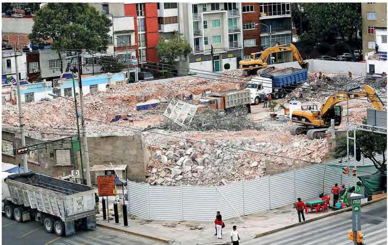
Imagen 54 Vista aérea de la demolición de la Octava de Narvarte Año 2014 (Derriban la Octava, inmueble protegido, Periódico Excelsior, 11 de Enero 2014)
