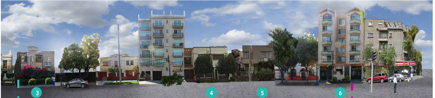
Imágen 68 Av. Dr. Vértiz entre Xola y La Morena año 2008, Zona 1(Larguillo realizado por el autor). ● Casas estilo colonial californiano que fueron destruidas
