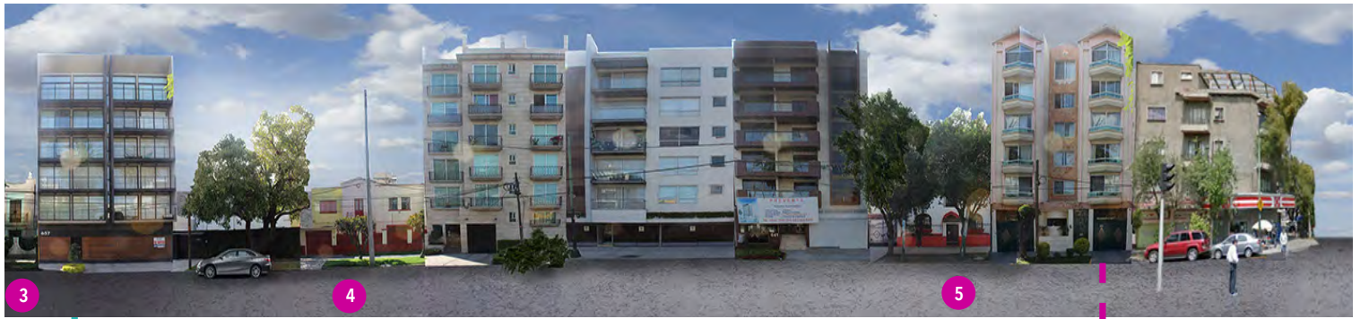
Imágen 67 Av. Dr. Vértiz entre Xola y La Morena año 2016, Zona 1 (Larguillo realizado por el autor). ● Casas estilo colonial californiano que permanecen
