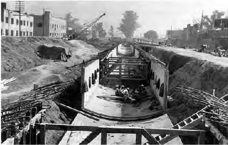
Imagen 14 En 1916 unos 70 ríos atravesaban la capital, como el de LA Piedad. Al crecer la mancha urbana, estos flujos se fueron contaminando y decidieron entubarlos como medida sanitaria y combatir las inundaciones recurrentes (Foto Archivo el Universal).
