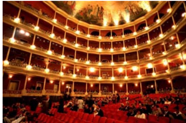
COLOCACIÓN DE BUTACAS E ILUMINACIÓN
