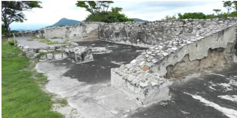
Figura 3.75. Fachada norte de la Estructura H4; se nota la elevación que bloquea medio acceso al cuarto central.
