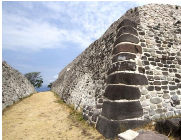
Figura 3.43. Pasillo entre el muro de contención sur del Sector G y la Estructura F1.
