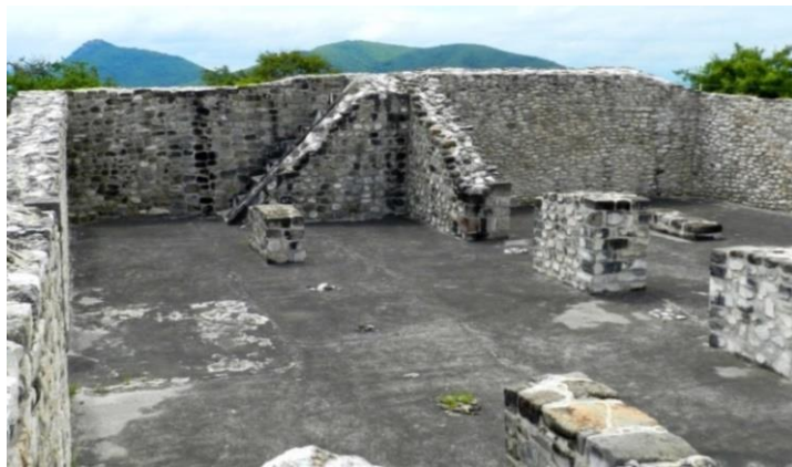
Figura 3.120. Cuartos 5 y 6; al fondo, la escalera adosada.
