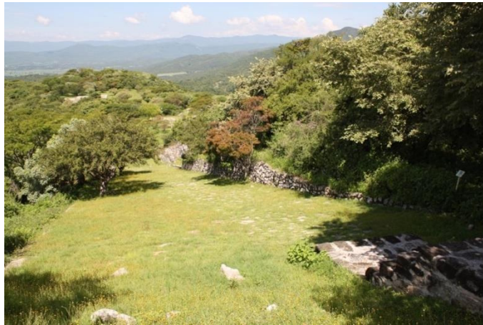
Figura 3.99. Vista de la calzada en dirección oeste, hacia el Sector N.
