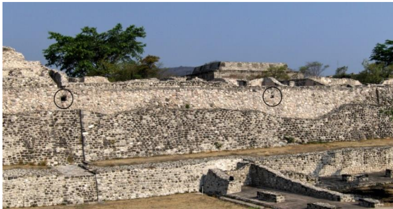
Figura A.29. Salidas de los drenajes procedentes de la Plaza Principal y de la Estructura G6 hacia el muro de contención que soporta el Sector G.
