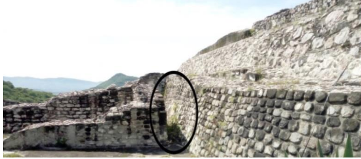
Figura 3.45. Drenaje entre las estructuras G6 y G8.
