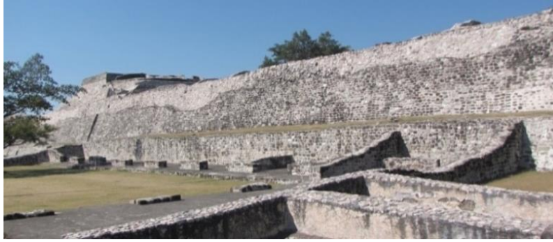
Figura 3.31. Estructura E2-3, adosada a la banqueta que corre al costado del muro de contención del Sector G.
