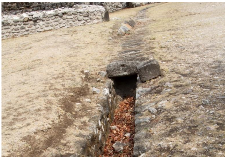
Figura A.30. Drenaje estucado y tapado con una losa.
