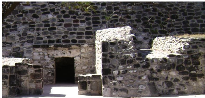
Figura 3.36. A la izquierda se ubica la Estructura E3-2, a la derecha se observa el límite de la banqueta que flanquea el muro de contención del Sector G.
