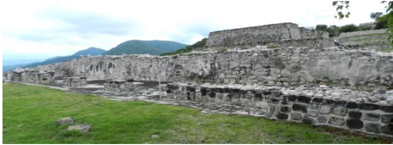
Figura 3.78. Fachada sur de la Estructura H5.
