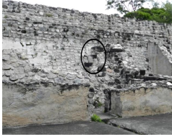
Figura 3.141. Escalones sobre el muro de contención de la Acrópolis, G12.
