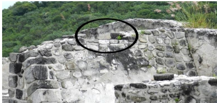
Figura 3.62. Ventana ubicada en el muro sureste del cuarto 4, G7.
