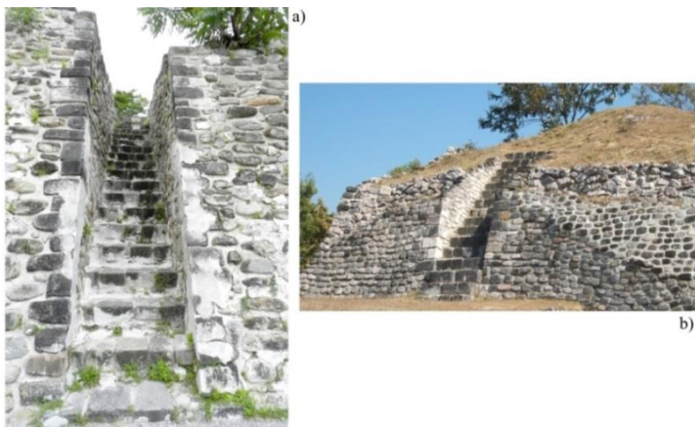
Figura A.25. Ejemplos de escaleras remetidas: a) en muro de contención, b) en plataforma.
