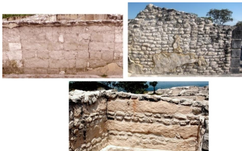
Figura A.3. Muros interiores de adobes, rocas andesitas careadas y con ambos materiales.
