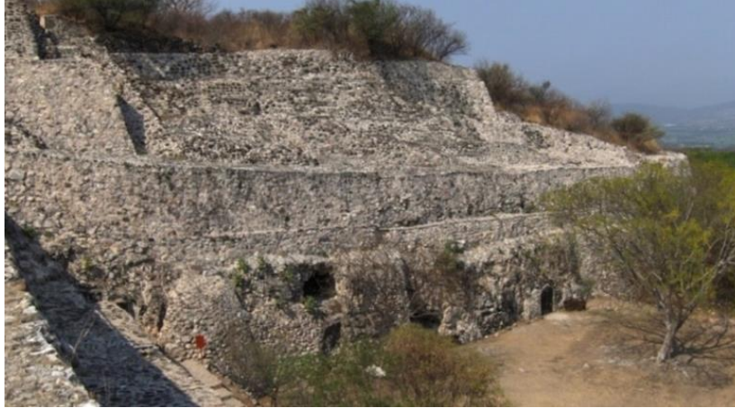
Figura 3.12. Muros de contención del Sector A, se notan las entradas a varias de las cuevas.
