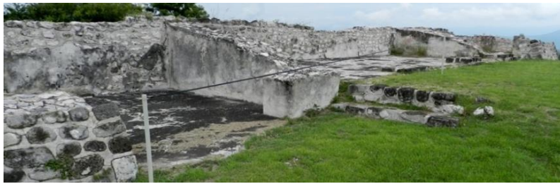
Figura 3.79. Fachada norte de la Estructura H5; se nota el desnivel de los cuartos.
