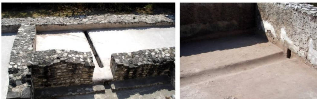
Figura A.31. Drenajes sin cubierta al interior de cuartos en las estructura G12 y Ac5.
