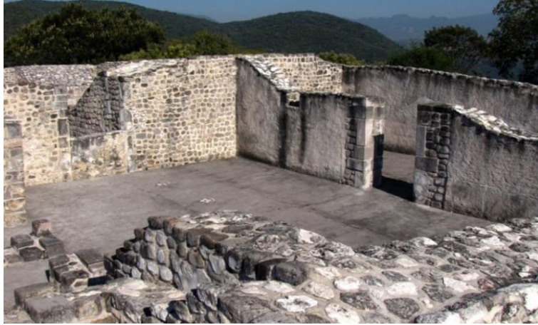
Figura 3.114. Cuartos 14 y 15. Del lado izquierdo se nota la tapia en el muro oeste y la ventana en el muro norte.
