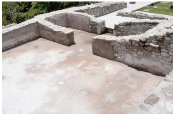
Figura 3.127. Vista desde el sur hacia los cuartos 6 y 7, Ac5.
