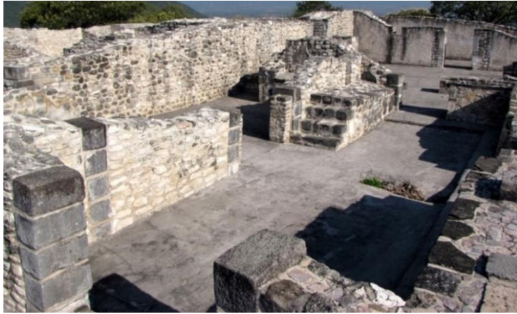
Figura 3.111. Patio 1 de la Estructura Ac8, se nota la escalera adosada al muro noroeste.
