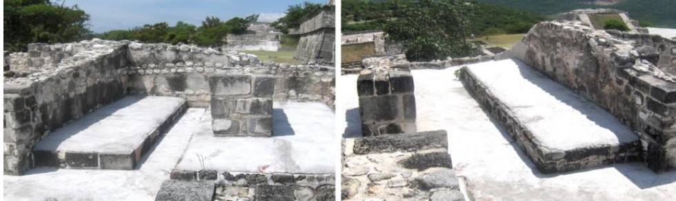
Figura 3.58. Bancas del cuarto 2c, G6. En la imagen de la izquierda se nota el pilar rodeado de una banca.
