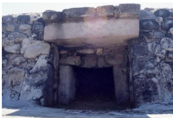
Figura 3.18. Cámara de combustión del Temazcal.
