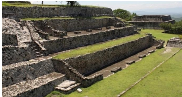
Figura 3.84. Estructura I10 o Doble Galería.
