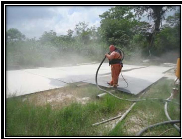
Figura 18. Aplicación de samblasteo y pintura RP-13.
