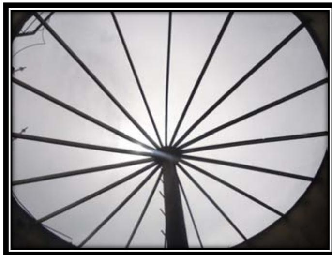
Figura 11. Ejemplo de Techo tipo cónico.
