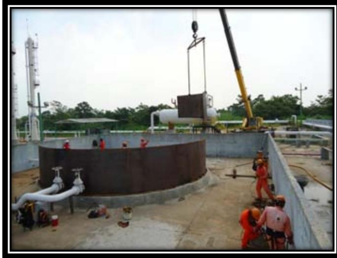
Figura 30. Montaje del primer anillo.
