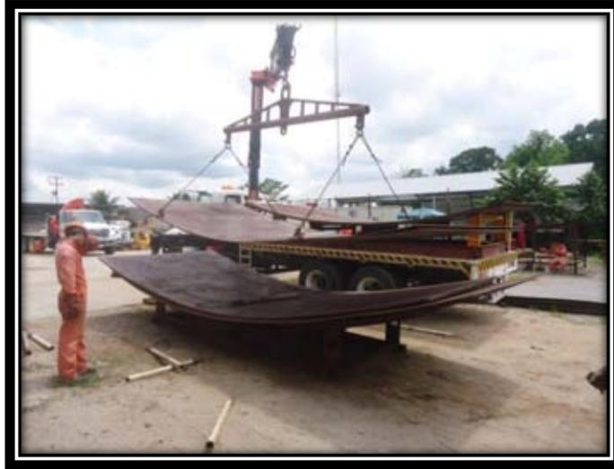
Figura 21. Descansos en el patín de carga de las placas
