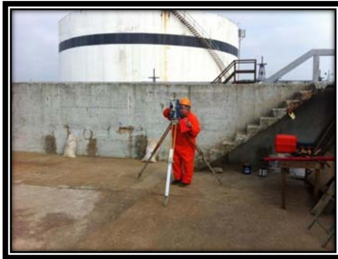
Figura 47. Inspección de tanque por método Estudio Verticalidad y redondez.
