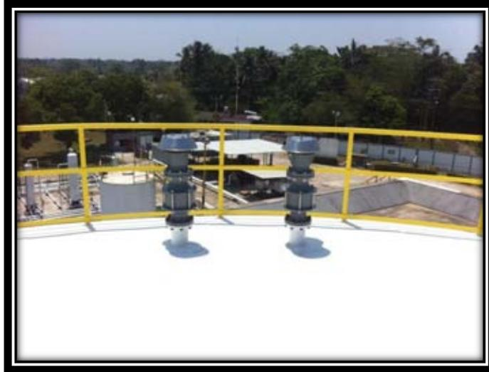
Figura 52. Habilitado válvula de expulsión y vacío.
