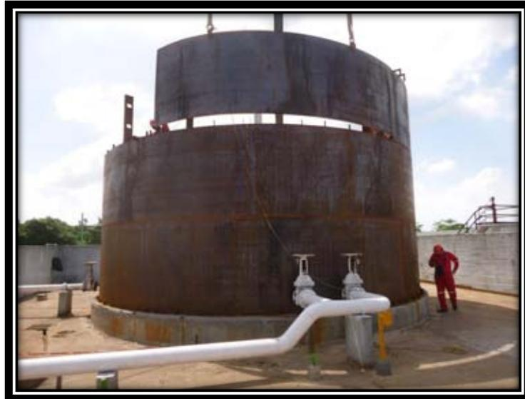
Figura 37. Colocación del tercer anillo.
