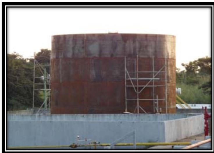
Figura 38. Colocación del cuarto anillo.
