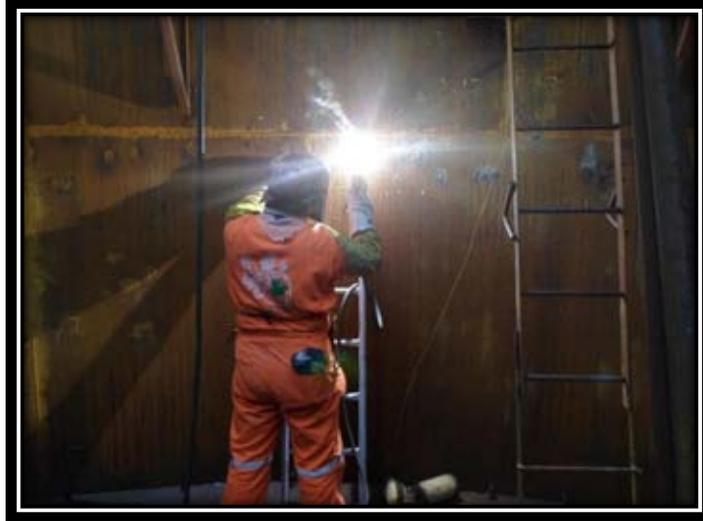
Figura 31. Soldadura en el primer anillo
