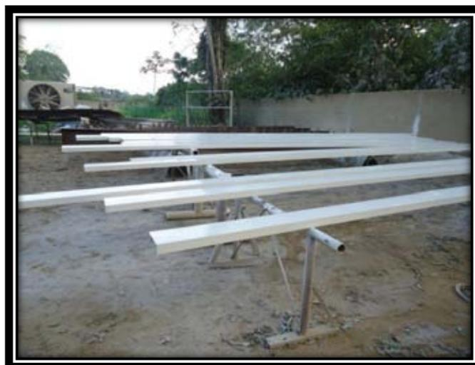
Figura 24. Habilitado de canales y aplicación de samblasteo y pintura.
