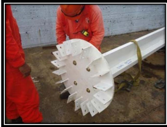
Figura 33. Armado del capitel en columna central.
