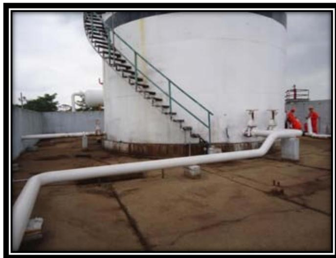
Figura 13. Escalera helicoidal de tanque TM-1 3 000 Bls.
