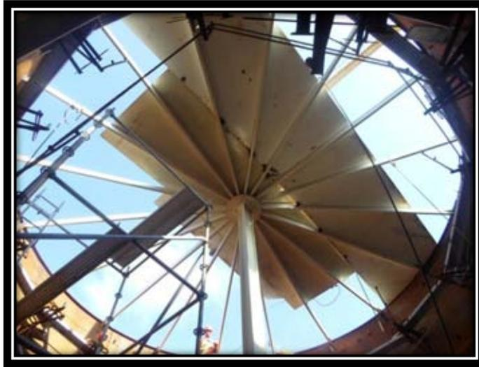
Figura 39. Cúpula o techo cónico y colocación de canales.
