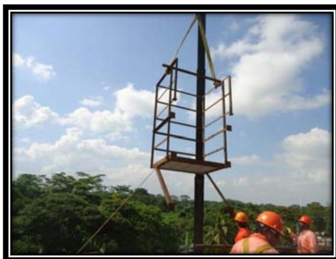
Figura 40. Montaje de canastilla para la cámara de espuma
