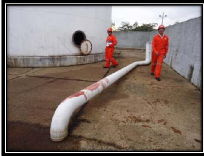
Figura 12. Ejemplo de boquilla de 24" entrada Hombre vertical.
