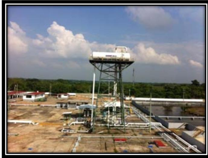
Figura 1. Ejemplo de Tanque elevado
